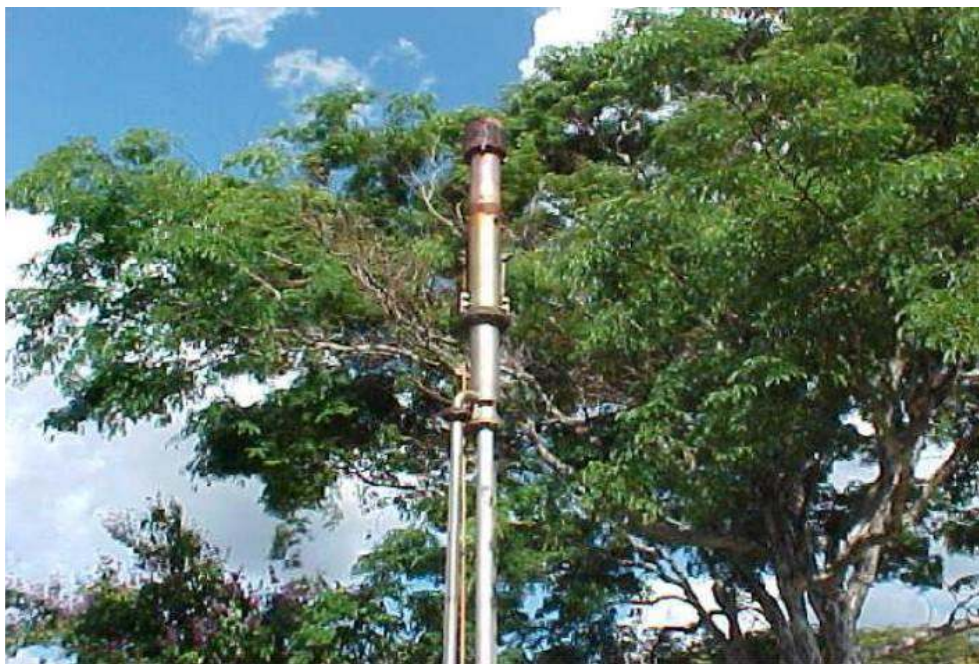
Figura 73 - Flare - Etapa do tratamento secundário da água utilizada pela Souza Cruz. Foto: (SOUZA, 2005, p. 50).
