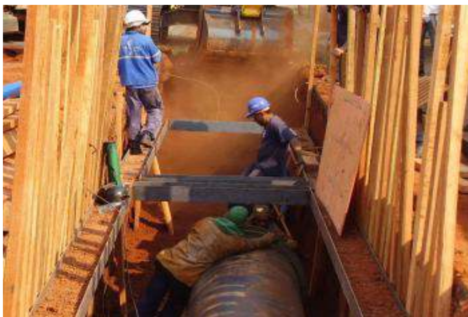
FIGURA 18 - Obras de expansão de adutoras no Distrito Industrial, 2007. Foto: DMAE, 2008.
