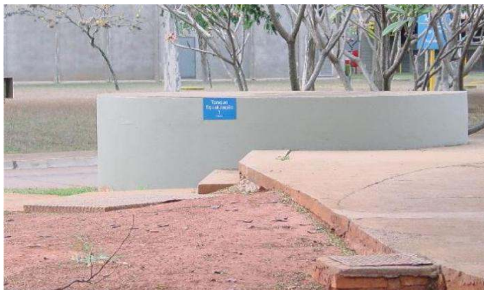
Figura 68 - Tanque de Equalização - Etapa do tratamento primário da água utilizada pela Souza Cruz. Foto: (SOUZA, 2005, p. 46).
