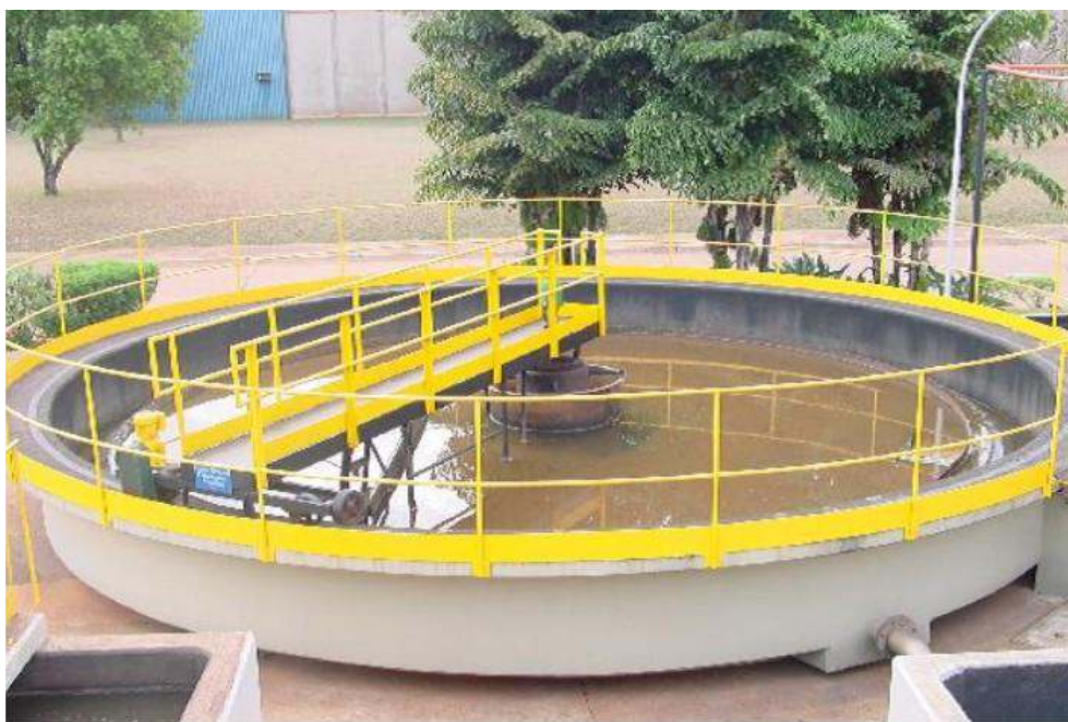
Figura 71 - Decantador primário - Etapa do tratamento primário da água utilizada pela Souza Cruz. Foto: (SOUZA, 2005, p. 48).
