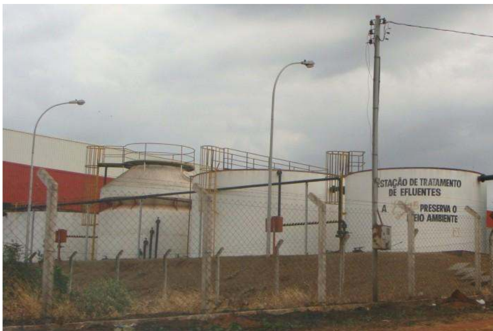
FIGURA 36 - Visão da Estação de Tratamento de Efluentes da Fábrica da Erlan em Uberlândia, em 20 de setembro de 2008. Foto: Clóvis Cruvinel, 2009.
