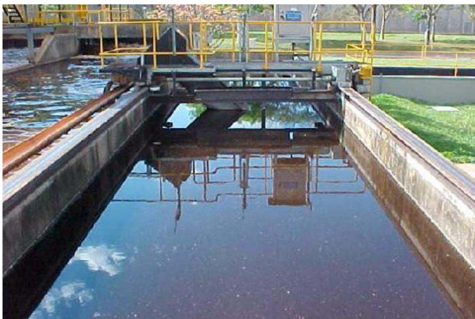
Figura 75 - Decantador secundário - Etapa do tratamento secundário da água utilizada pela Souza Cruz. Foto: (SOUZA, 2005, p. 50).
