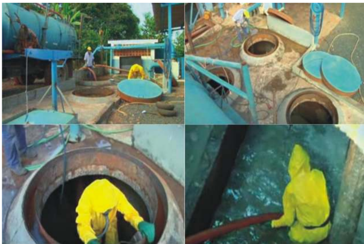
FIGURA 15 - Manutenção das redes e estações elevatórias por funcionários do DMAE de Uberlândia. Fonte: ÁGUA, 2009.
