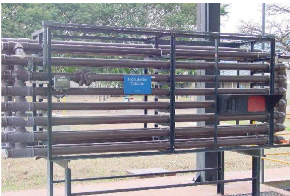
Figura 77 - Floculador tubular - Etapa do tratamento Terciário da água utilizada pela Souza Cruz. Foto: (SOUZA, 2005, p. 54).
