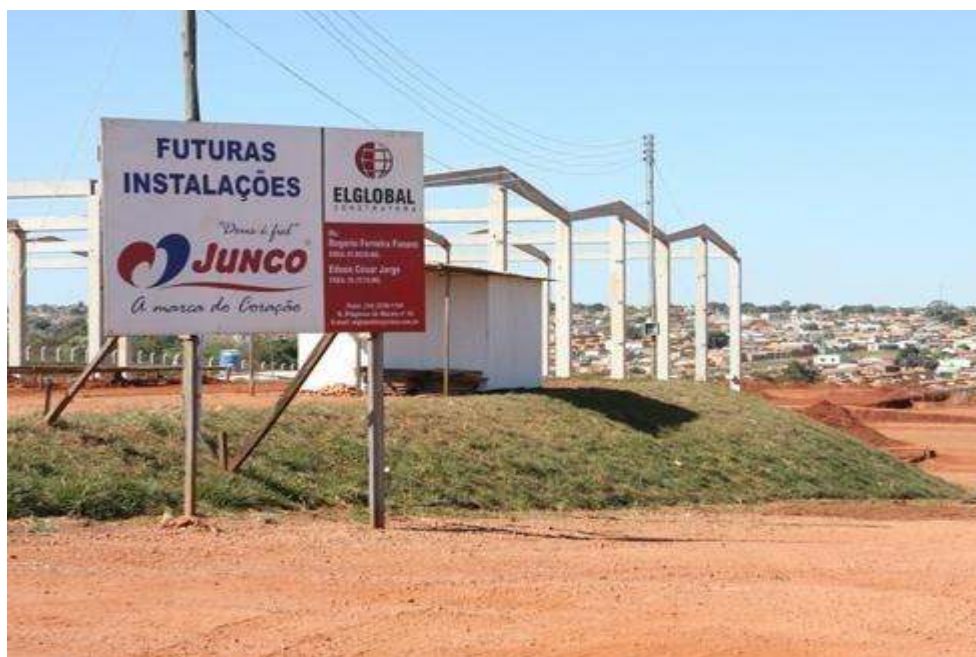
FIGURA 17 - Futuras instalações industriais da JUNCO. Foto: Correio de Uberlândia, 2008.
