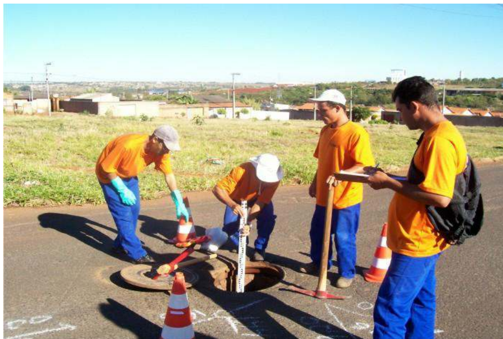
FIGURA 13 - Recadastramento de redes de esgoto por funcionários do DMAE em 2008. Foto: DMAE, 2008.
