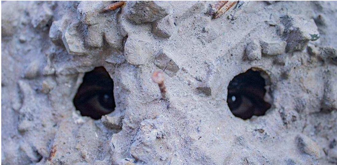
Figura 19 - Olhos do Monstro de Concreto.
