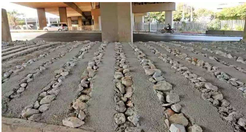
Figura 5 - Instalação de pedras sob viadutos.
