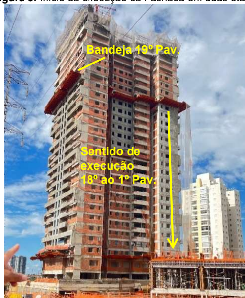
Figura 5: Início da execução da Fachada em duas etapas
