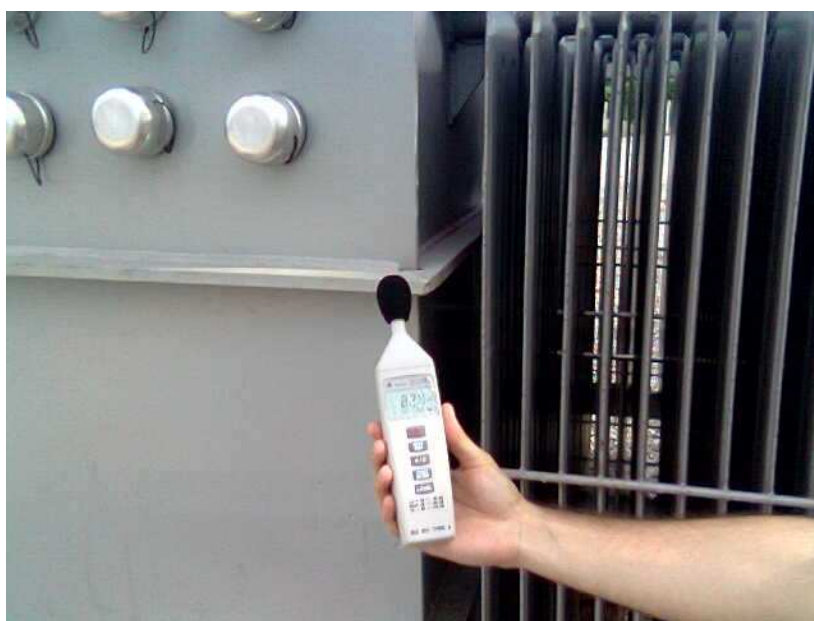
Figura 4.37 - Medição de ruído.
