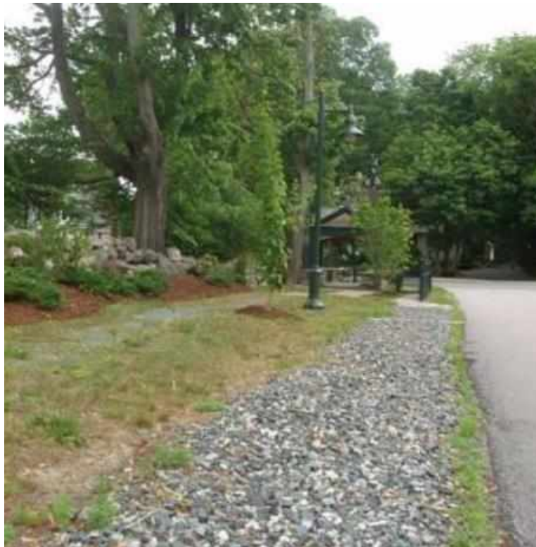
Figura 16: Trincheira de infiltração, North Kingstown.
