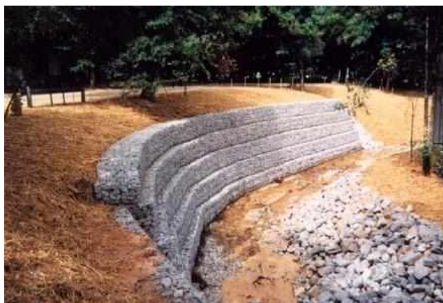
Figura 20: Gabião tipo caixa, que pode ser implanto no córrego para conter as erosões.
