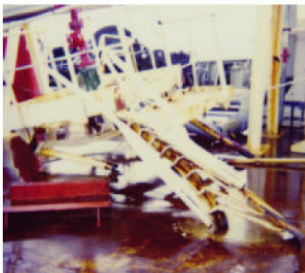
Figura 3.1 – Danos causados à plataforma de combate a incêndios da Emerald FSU por água verde. Fonte: Kleefsman (2005)
