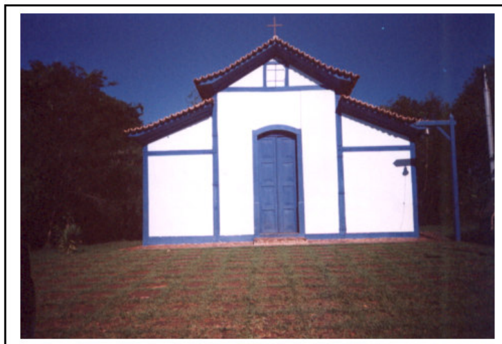
Figura 15 – Miraporanga: Igreja Nossa Senhora do Rosário Autora: MONTES, S. R. (2003).
