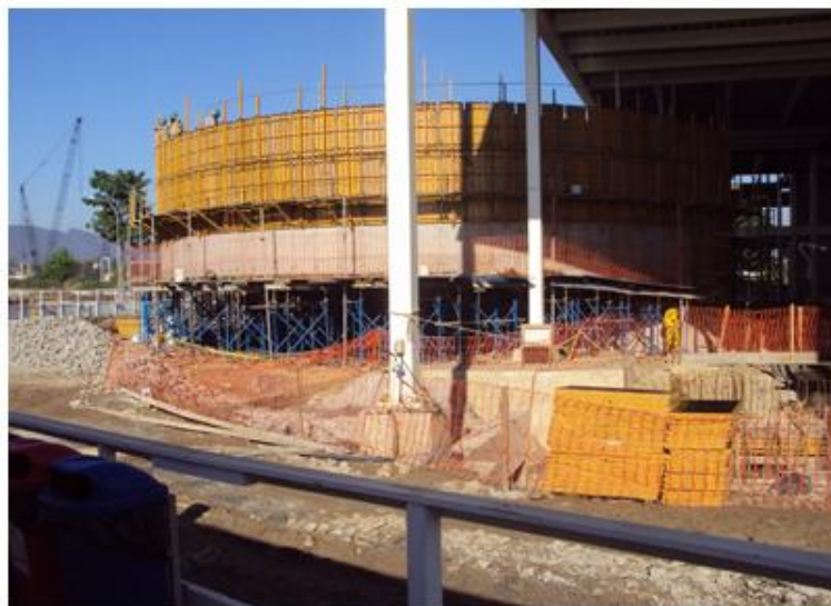
Figura 15 – Sistema de fôrma metálica na construção do auditório do campus universitário UFRJ.
