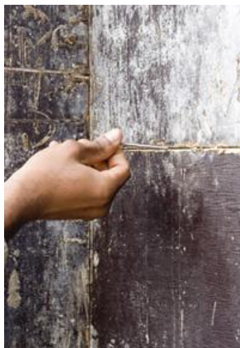
Figura 17 – Verificação da estanqueidade. Fonte: Técnica (2006)
