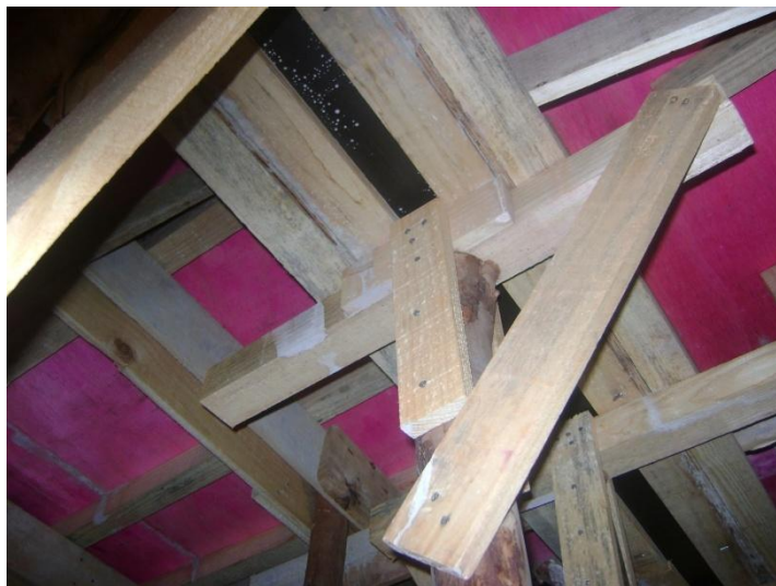
Figura 50 – Painel de fundo das vigas
