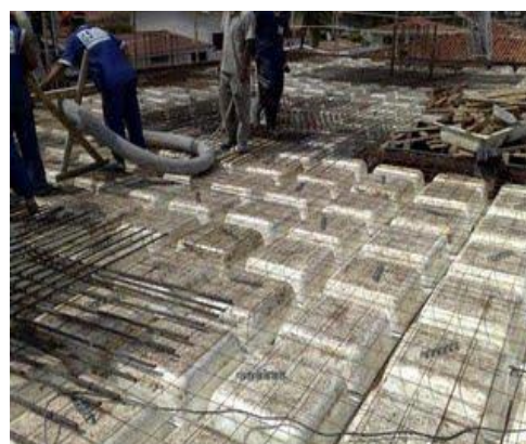
Preparo para o lançamento do concreto
