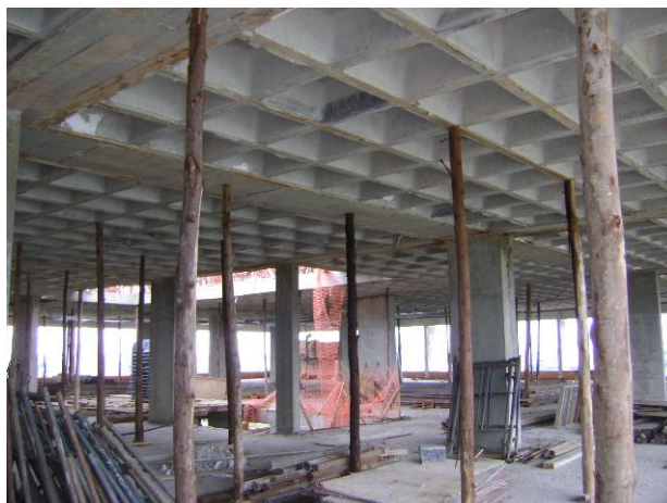
Figura 31 – Reescoramento em eucalipto de laje e viga
