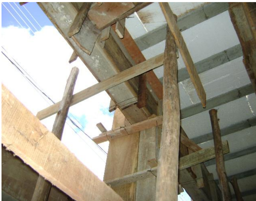
Figura 27 – Escoramento de viga em obra de Goiânia
