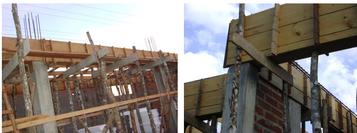
Figura 34 – Fôrmas e escoramentos na cidade de Morrinhos
