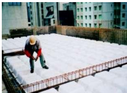
Figura 12 – Fôrma em polipropileno para lajes nervuradas. Fonte: http://www.astra-sa.com.br/criativos/site/2002/pro_indice.asp?linha=220 (2010)
