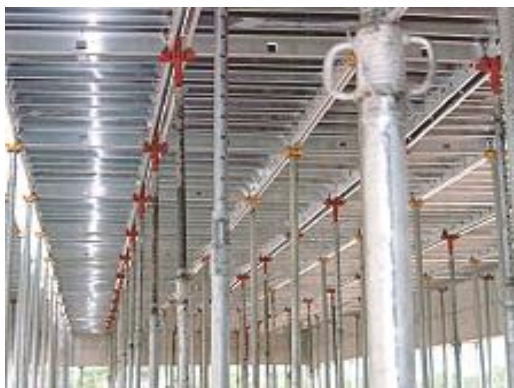
Figura 9 – Fôrma de alumínio tipo Deck. Fonte: Técnica (2009)
