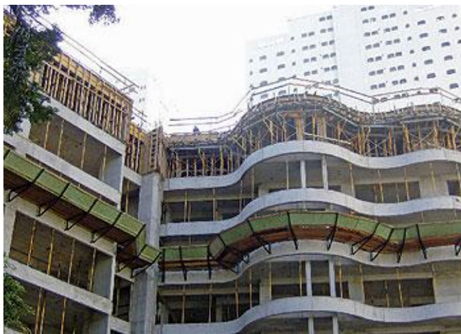
Figura 1 – Fôrmas de madeira. Fonte: Técnica (2009)
