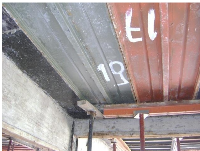
Figura 28 – Fôrma de laje de chapa metálica corrugada
