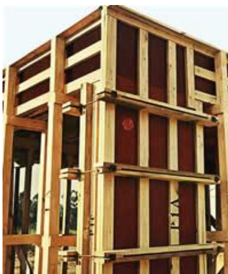
Figura 3 – Montagem de fôrmas de madeira. Fonte: Técnica (2007)
