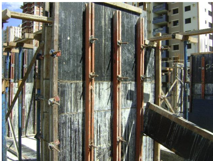
Figura 29 – Travamento das fôrmas de um pilar (parafusado)
