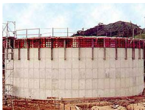
Figura 5 – Fôrma trepante. Fonte:
