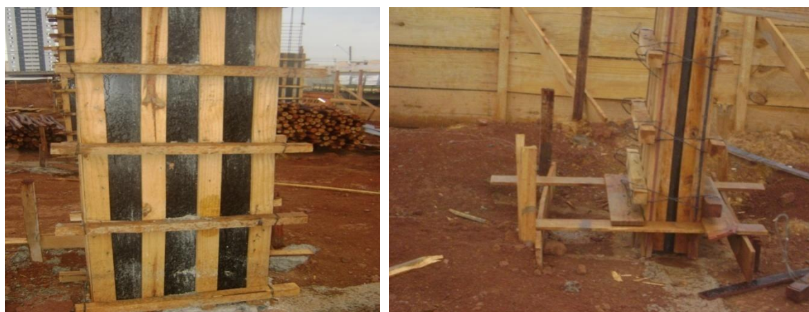
Figura 52 – Fôrmas dos pilares
