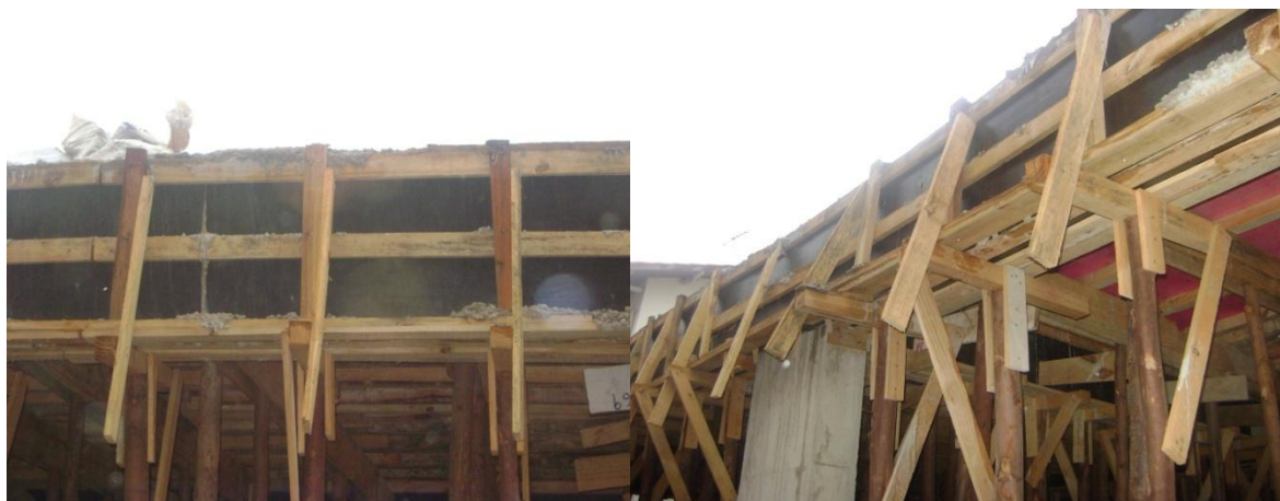
Figura 51 – Fôrmas e escoramentos das vigas
