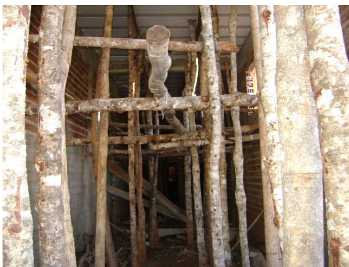
Figura 36 – Materiais utilizados para o escoramento de obra em Morrinhos
