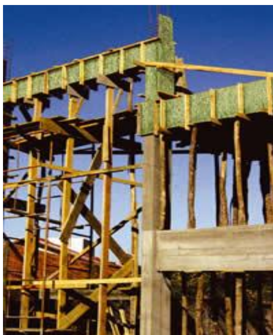
Figura 6 – Fôrmas em OSB. Fonte: Técnica (2007)
