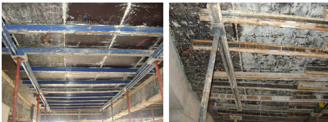
Figura 30 – Guias e travessões metálicos em escoramento de laje
