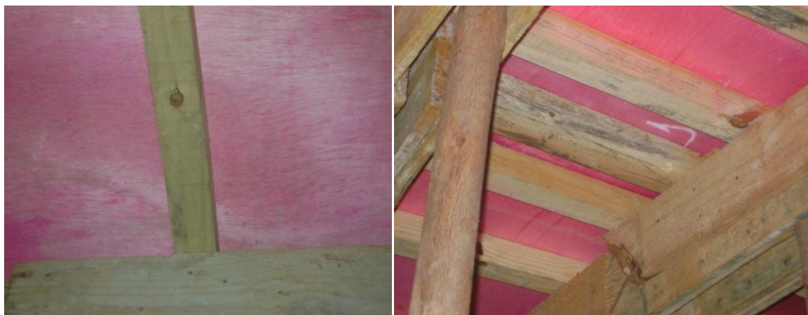
Figura 48 – Transversinas adotadas na obra
