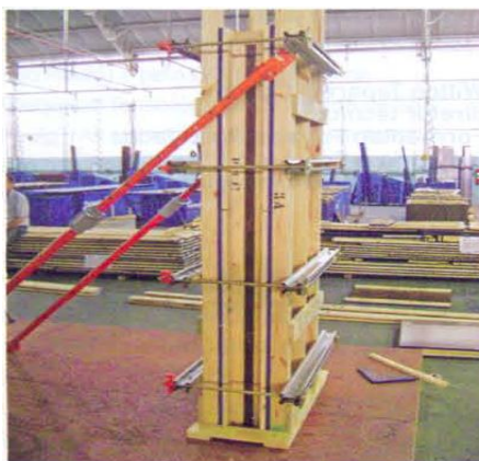
Figura 21 – Montagem de um painel para pilar com fôrmas pré-fabricadas. Fonte: Técnica (2009)
