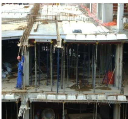
Início da montagem
