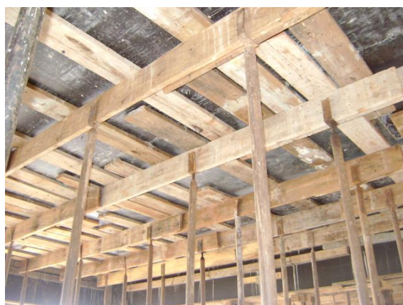
Figura 32 – Escoramentos metálicos, guias e travessões
