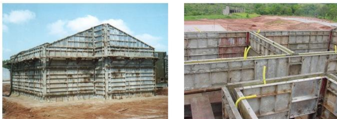
Fôrma de vedações
