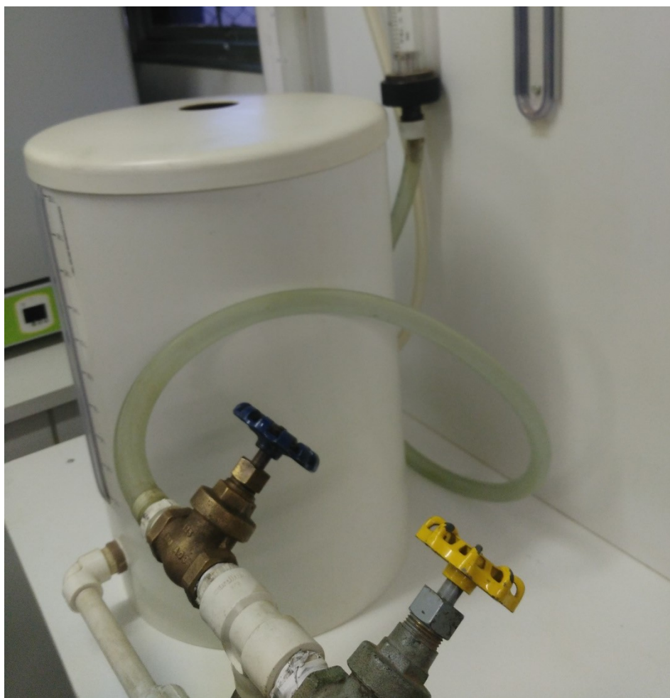
Figura 3.5 Mangueira que faltava para ligar a bomba ao Leito 1
