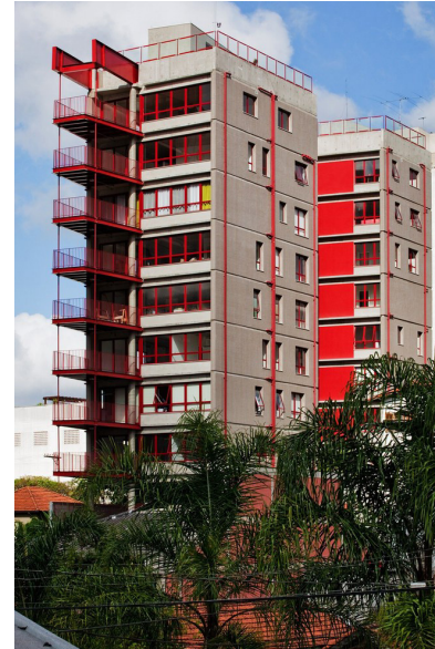
FIG. 12: EDIFÍCIO HABITACIONAL NA RUA SIMPATIA - GRUPOSP
