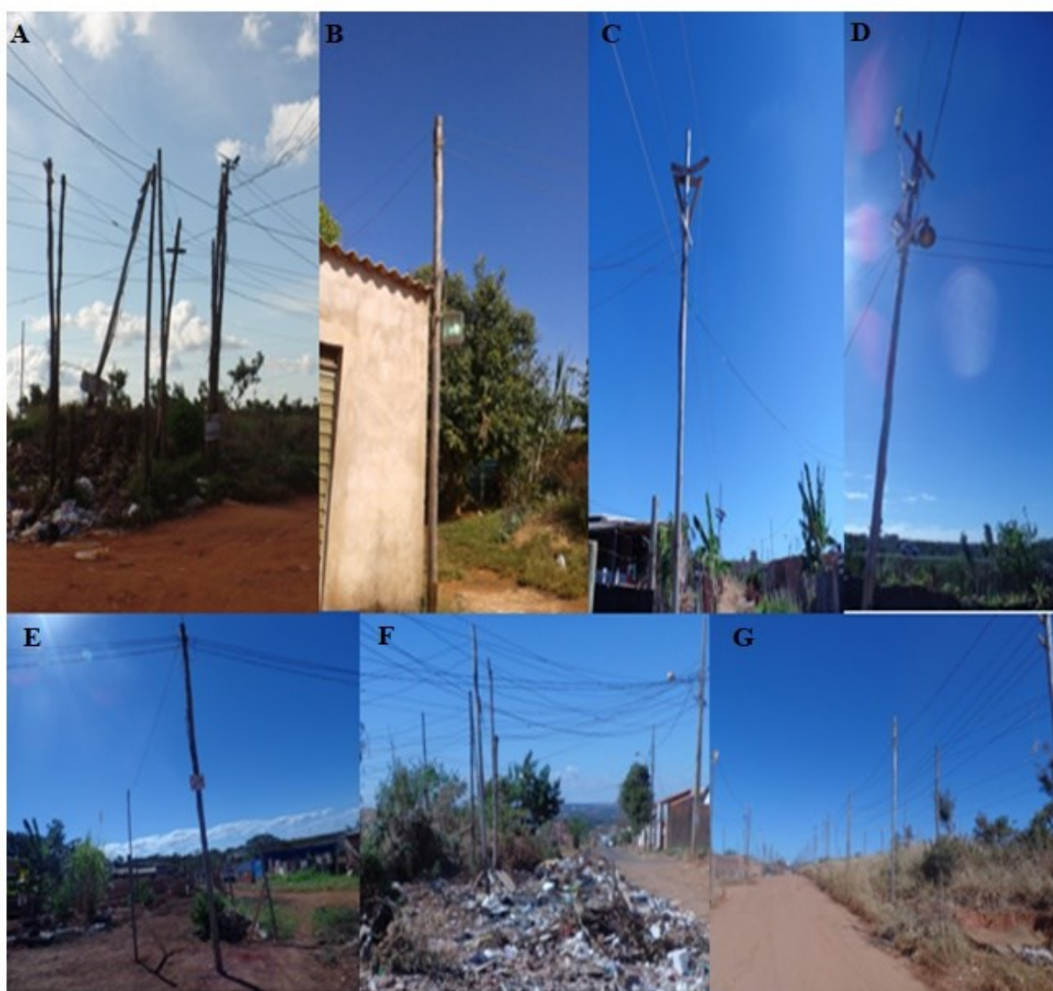
Mosaico 11- Estrutura da Rede Elétrica no Assentamento do Glória
