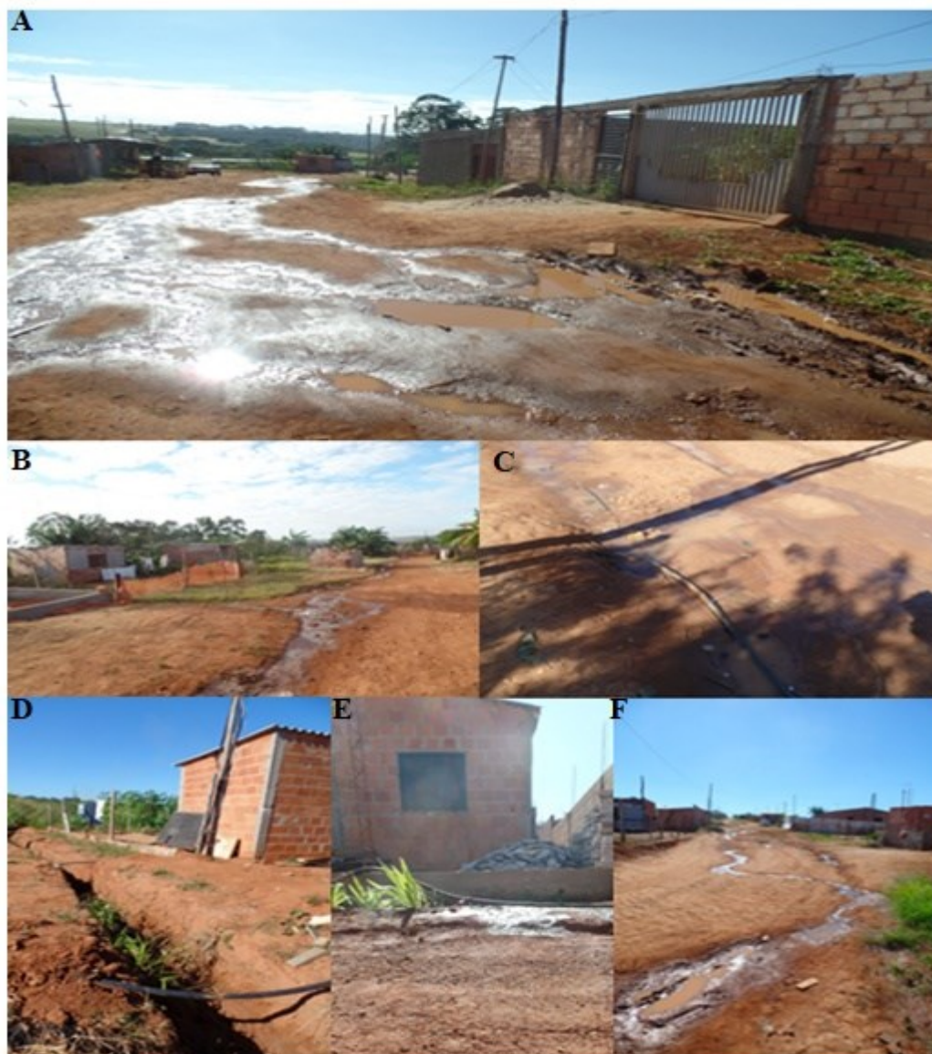
Mosaico 4- Vazamentos de água potável no Assentamento do Glória
