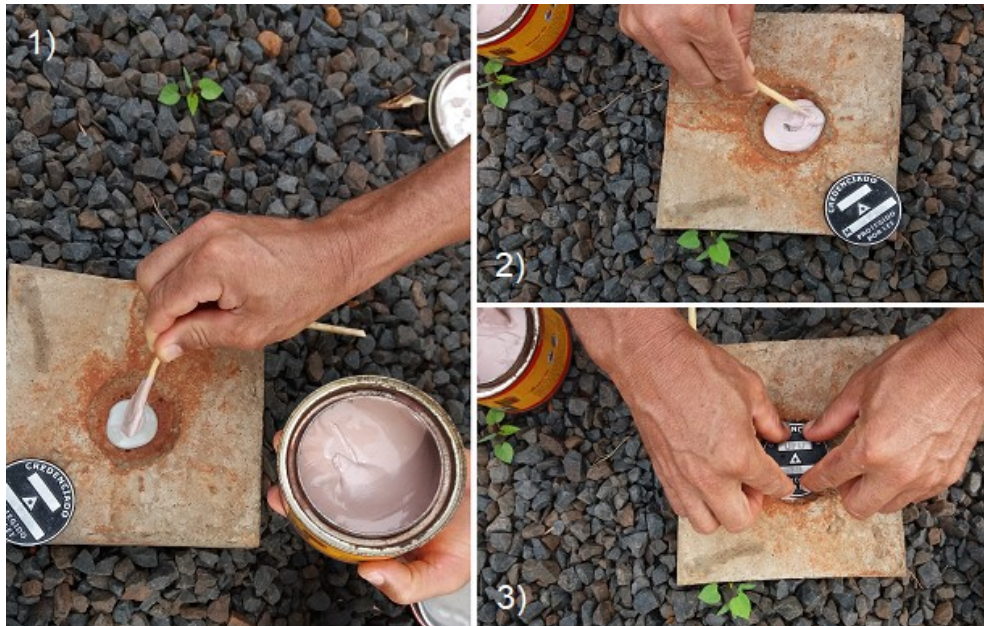
Figura 12 – Fixação das chapas metálicas aos marcos.
