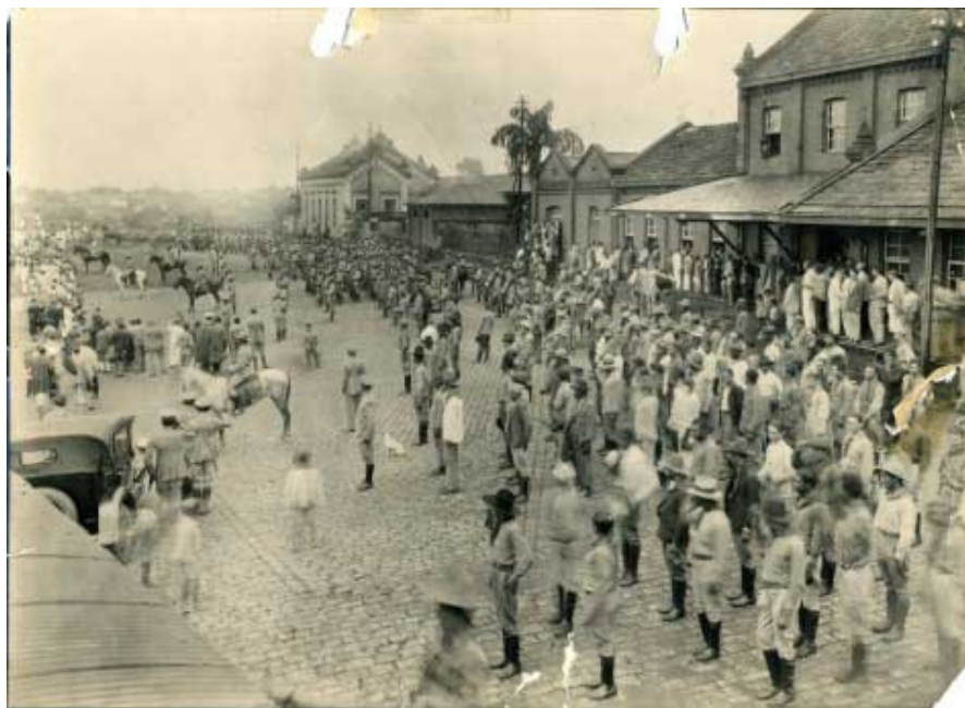
Figura 10 - Inauguração da Estação da Mogiana de Uberaba, 1889.
