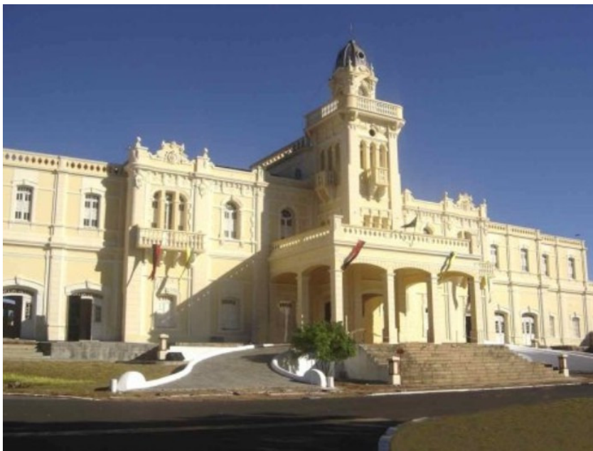
Figura 13 - Estação da Estrada de Ferro Goiás, 2005.
