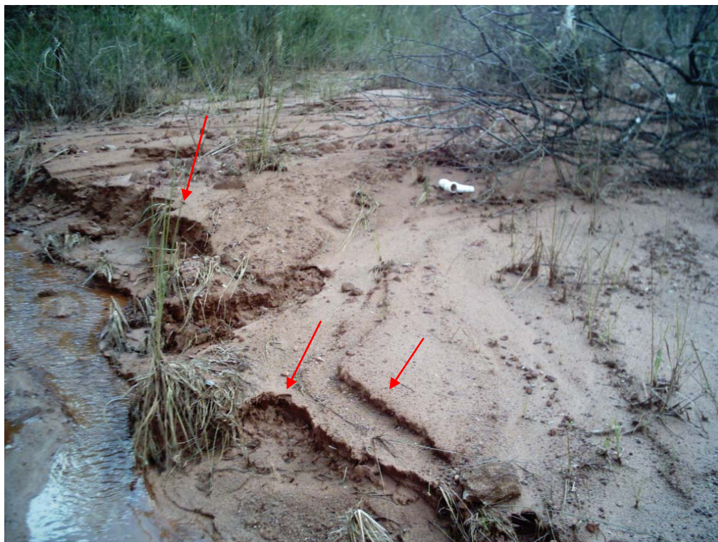
Fig. 28 - Sulcos formado pelo escoamento superficial no interior da voçoroca. Notar que os sulcos cortam o sedimento depositado no fundo da erosão. Em destaque diferentes níveis de depósitos.
