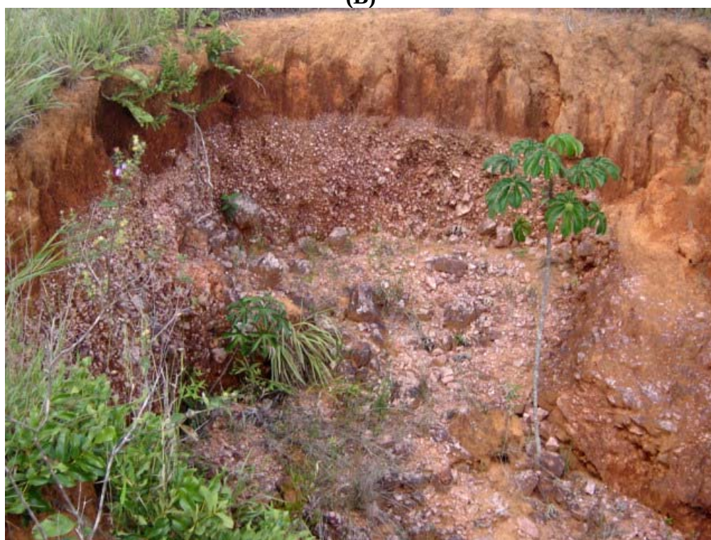
Fig. 10- (A) Vista geral das paredes da voçoroca. (B) Detalhe do perfil, camada superficial e camada de cascalho quartzítico.
