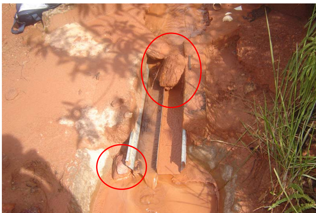
Fig. 39– Transporte de material no interior da voçoroca. Blocos de 25 cm. Autor: ROCHA, E. A. V., mar. / 2005.
