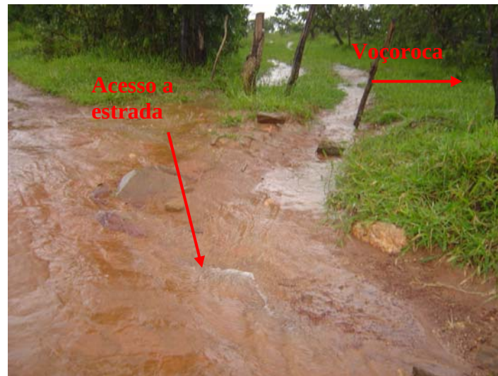
Fig. 24– Fluxo de escoamento pluvial desviado para a estrada.
