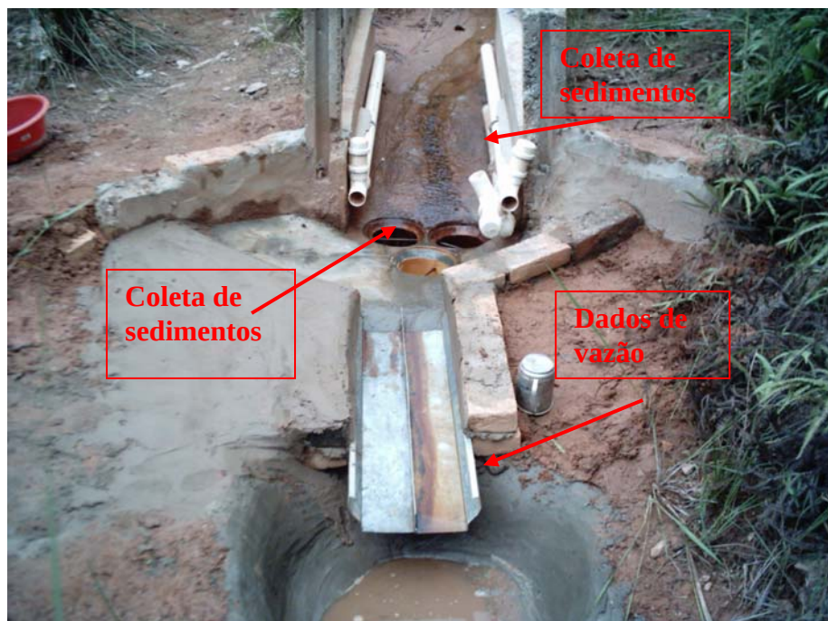
Fig.07 – Vertedouro montado no interior da voçoroca. Autor: ROCHA, E. A. V., mar. /2005.
