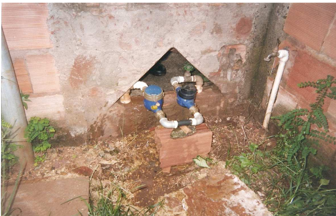
Figura 3.2 - Cavalete experimental instalado em campo.
