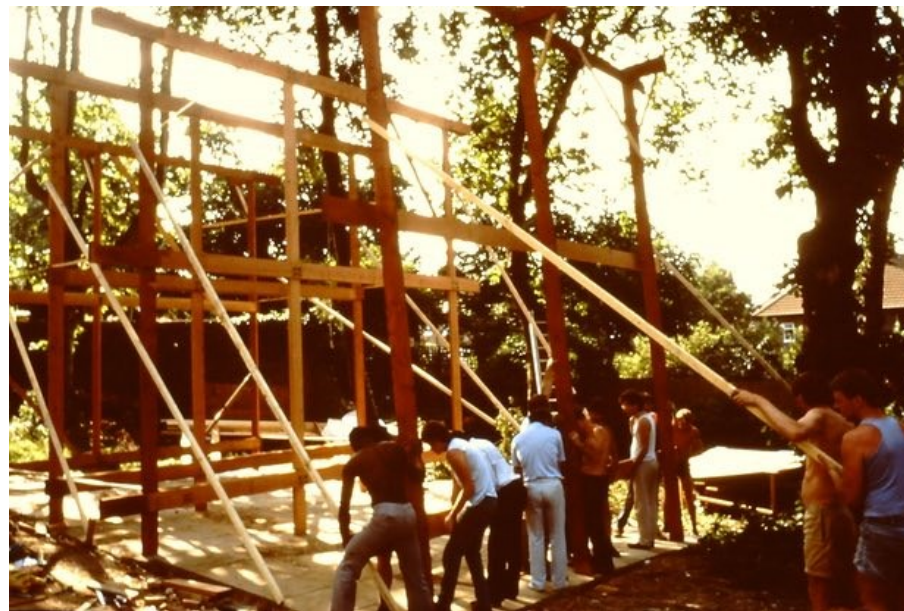
Figura 3: Construção do projeto de habitação, Walter's way
