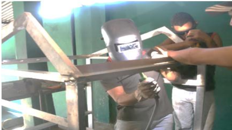
Figura 3.1 – Construção do Dessalinizador Solar. Fonte:: Lopes (2013)
