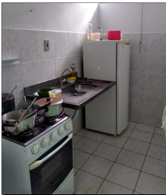
Figura 28 – Ituiutaba/MG: vista parcial da Cozinha do PSF Sol Nascente, 2019
