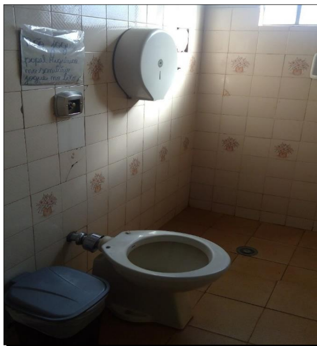
Figura 43 – Ituiutaba/MG: vista parcial do banheiro PSF Novo Horizonte, 2019
