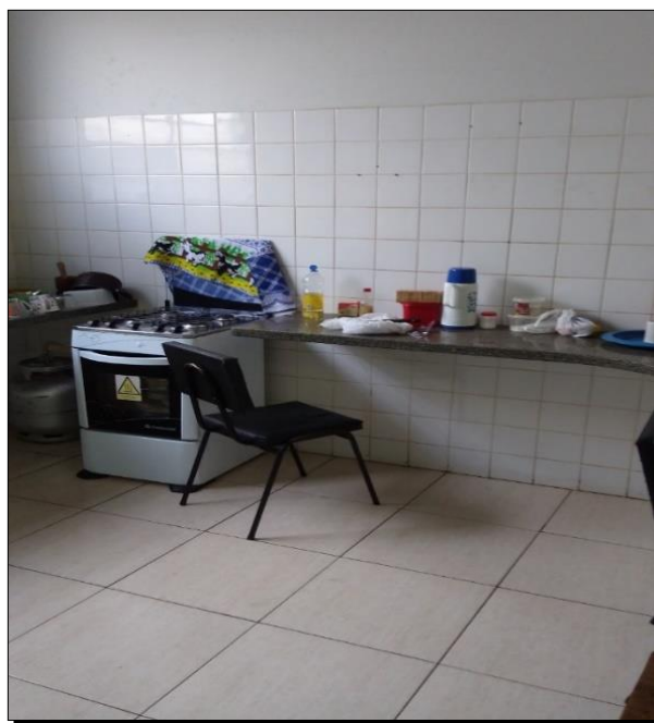
Figura 36 – Ituiutaba/MG: vista parcial da cozinha do PSF Camargos, 2019
