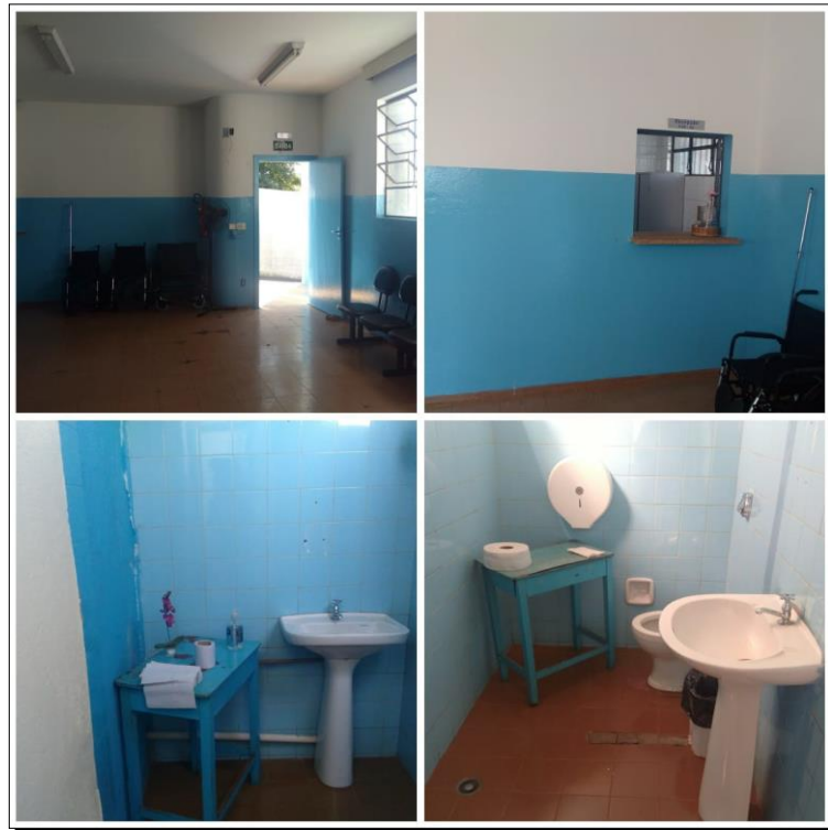
Figura 52 – Ituiutaba/MG: vista parcial da Recepção e Banheiros externos PSF Alvorada, 2019
