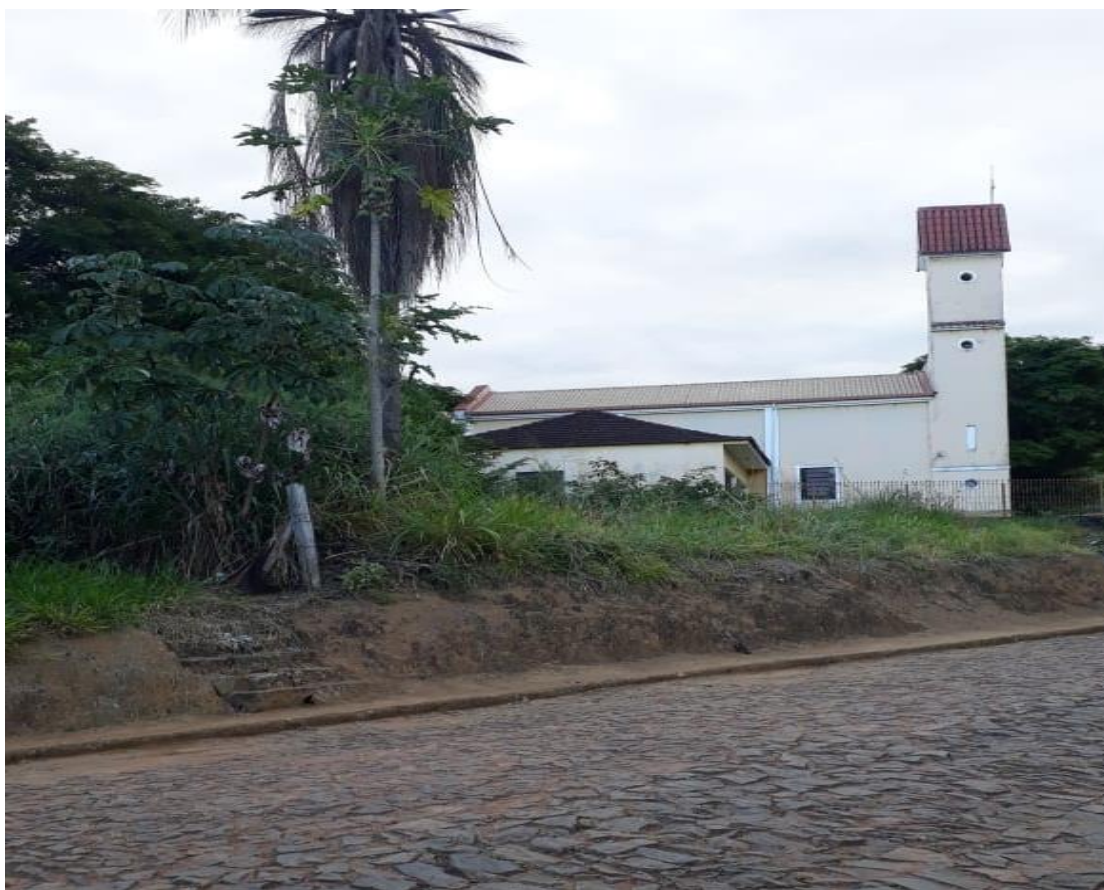
Figura 3 – Terreno da Casa Escolar Combinadas de Ituí Fonte: Arquivos da Escola.
