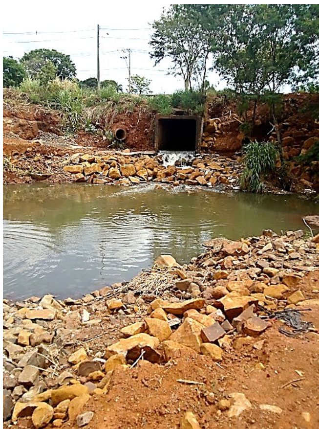
Figura 8 – Canalização do Córrego do Óleo, na Rua Ivo Morganti - Bairro Dona Zulmira.
