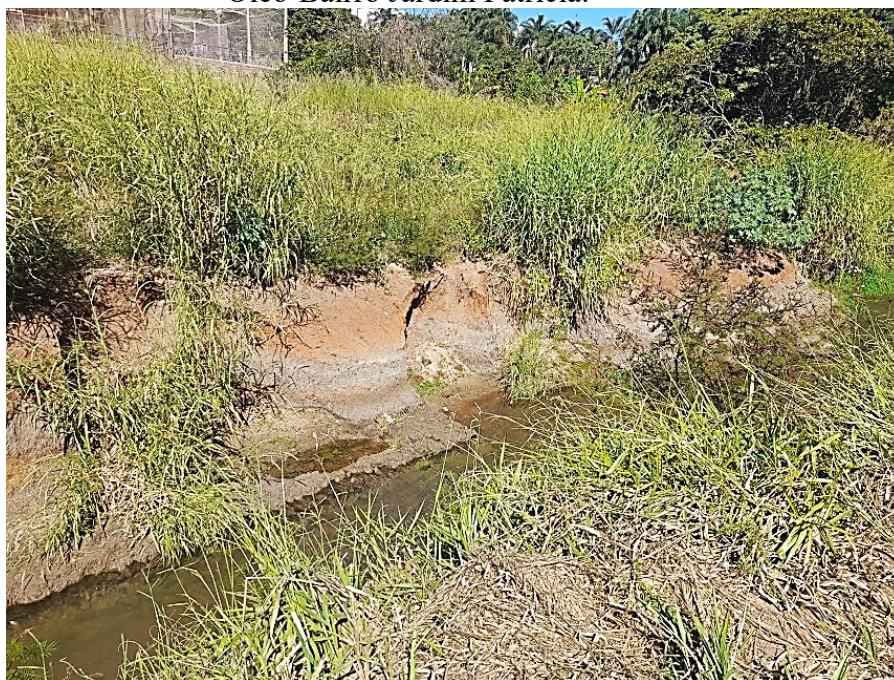
Figura 6 – Erosão nas margens do córrego do óleo, já no baixo curso, na Avenida Do Óleo-Bairro Jardim Patrícia.
