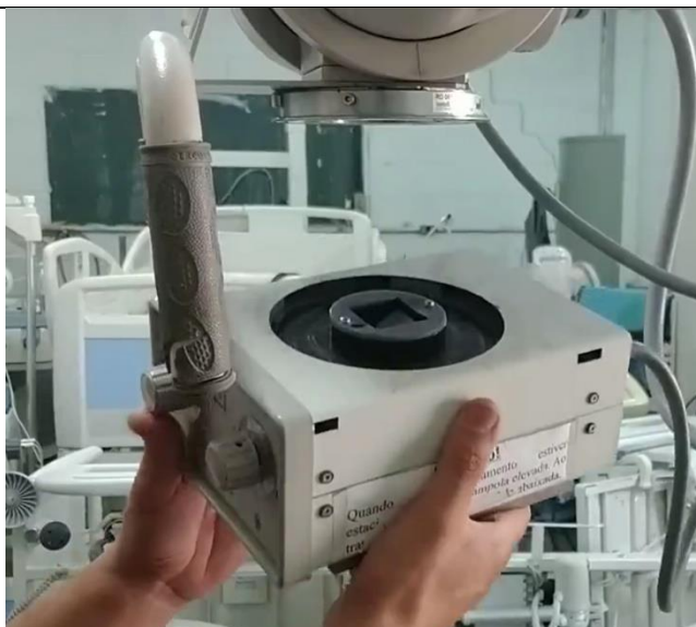
Figura 45: retirando o colimador com segurança
