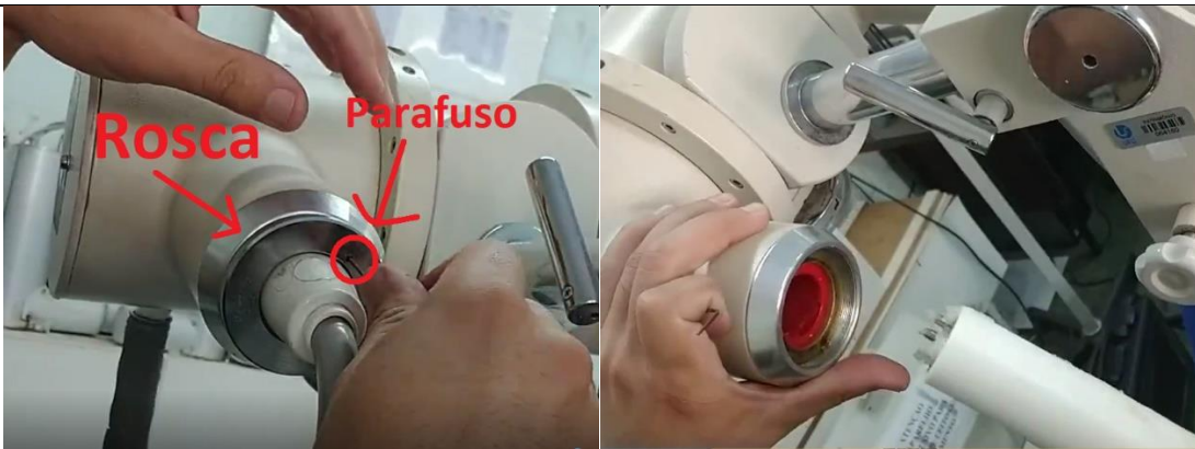
Figura 47: retirando os cabos de alta tensão do equipamento
