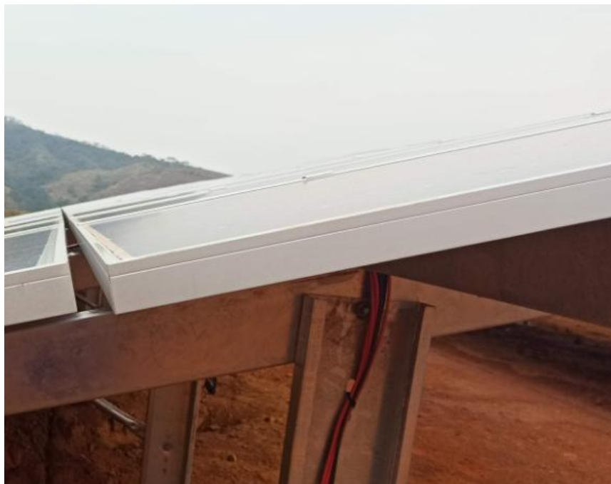
Figura 8 - Moldura de um módulo fotovoltaico
