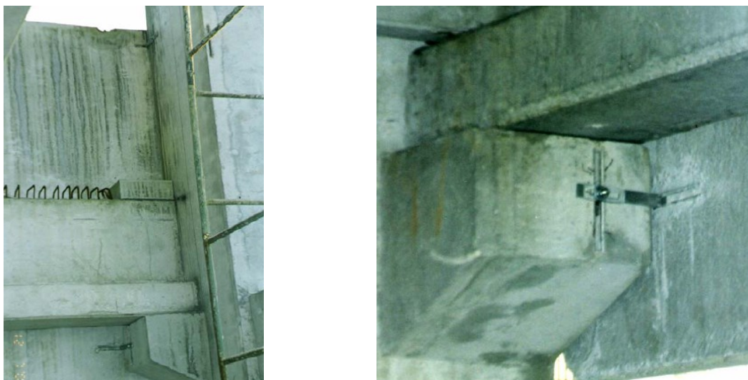
Figura 11 – Ligação dos painéis longitudinais
