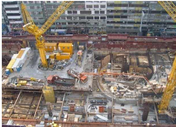
Figura 2 – Canteiro de obras restrito
