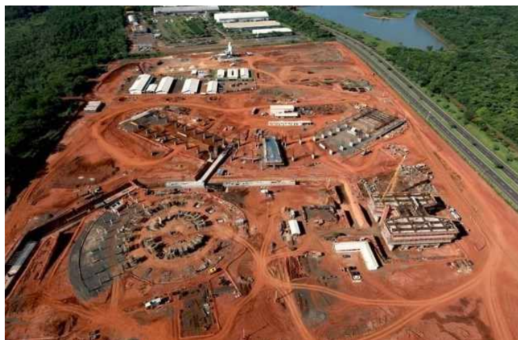
Figura 1 – Canteiro de obras amplo
