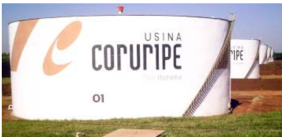
Foto 5 – Iturama/MG: Usina Coruripe – Filial Iturama/Tanques de Armazenamento de Etanol
