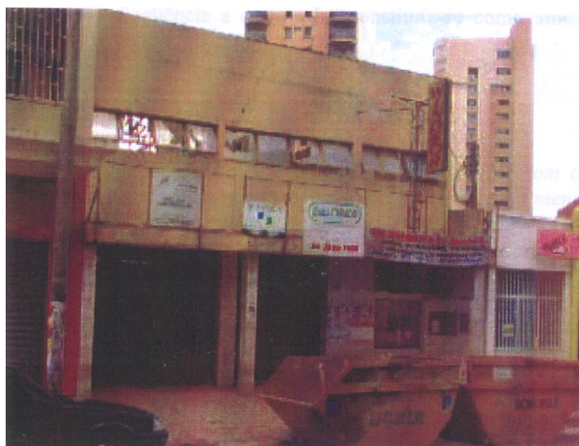
FIGURA 23: Fachada do prédio do antigo Cine Windsor em 2004.
