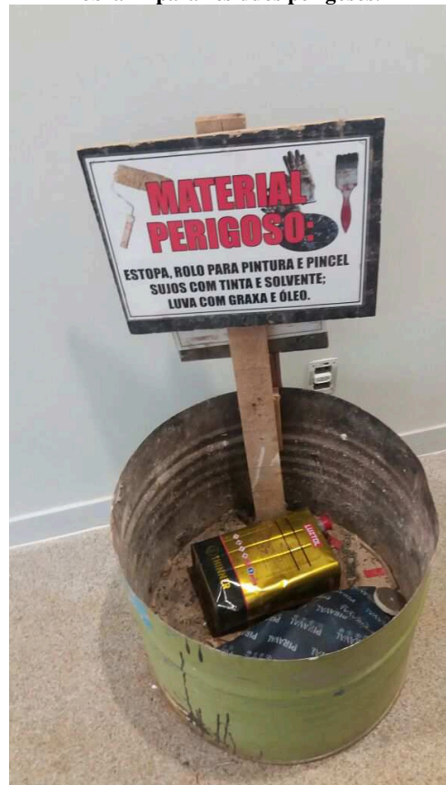
Figura 7 - Recipientes espalhados no canteiro da obra M para resíduos perigosos.
