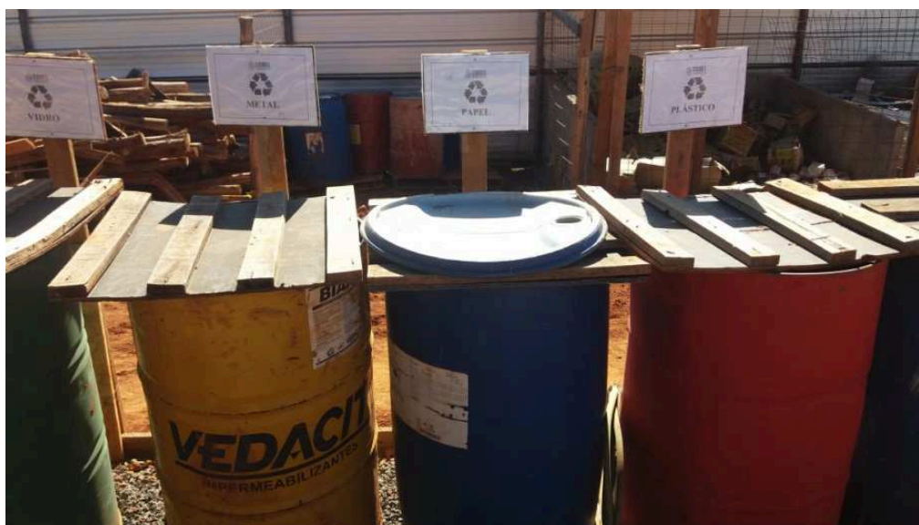
Figura 9 - Coleta seletiva no canteiro da obra M.
