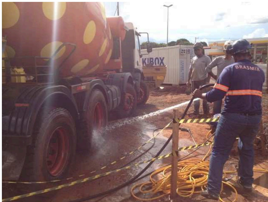
Figura 13 - Sistema lava-rodas da obra M, utilizando águas pluviais.
