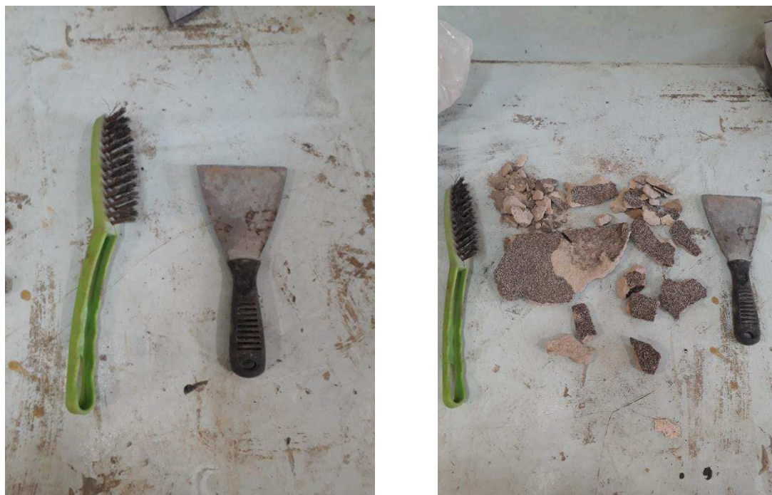
Figura 11 – Materiais utilizados para limpeza da argamassa convencional
