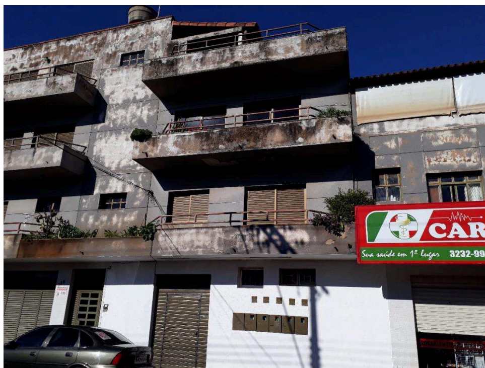
Figura 6 – Edifício escolhido com fachada argamassada.
