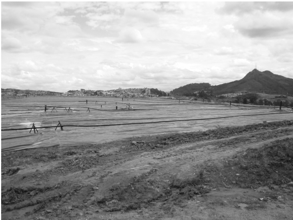
Figura 01: Geomembrana de PEAD (Polietileno de Alta Densidade) usada para impermeabilização do solo no aterro.
