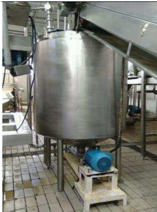
Fotografia 13. Esteira de saída de resido.
