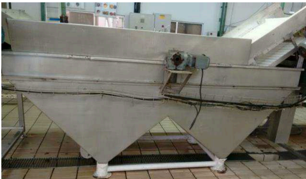
Fotografia 5. Esteira de saída do tanque de cloro
