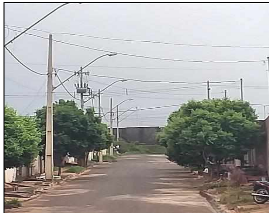
Figura 5 – Vista do muro do Condomínio Ituiutaba, ao final de uma rua do Conjunto Habitacional Gilca V. Cancell
