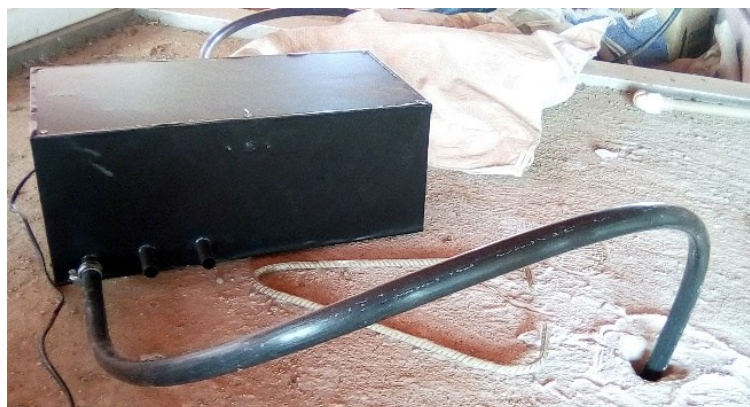
Figura 5.7 – Subsistema de válvulas instalado, com encanamentos flexíveis para transporte da água usada na cura.
