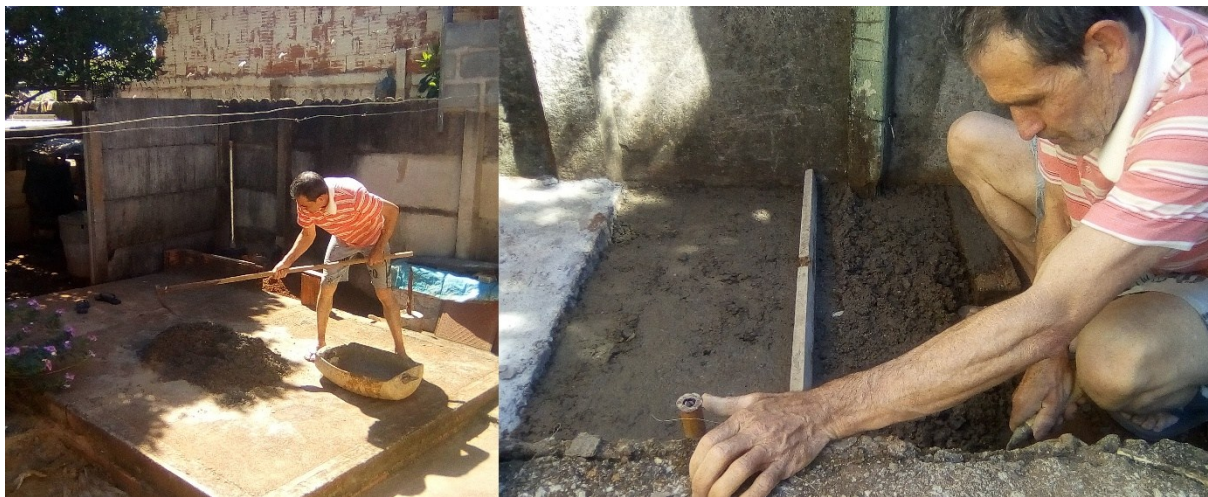
Figura 5.13 – Concretagem da nova área de teste.
