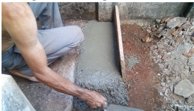
Figura 5.10 – Concretagem da área de teste.
