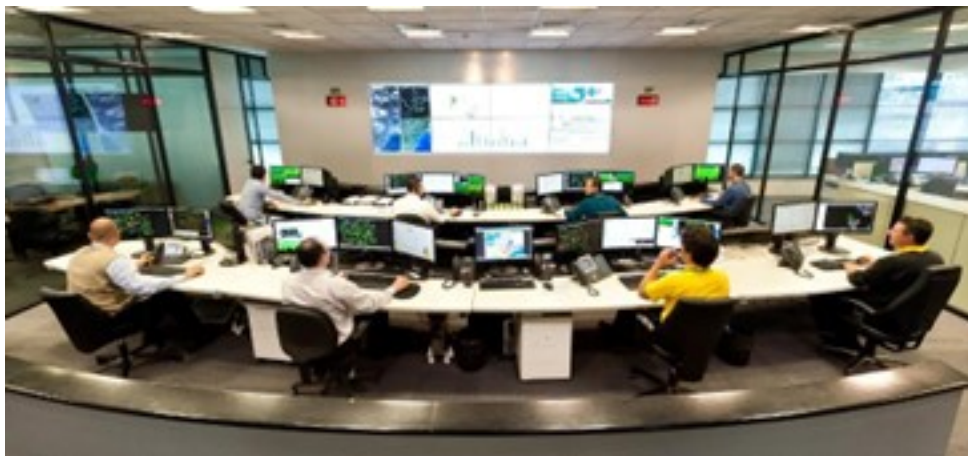
Figura 2 – Centro de operações com a utilização de um sistema SCADA.
