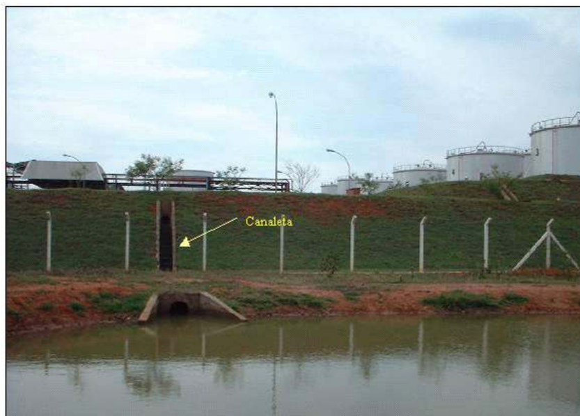
Figura 3.1 - Lagoa mostrando a canaleta e o bocal de descarga do efluente na mesma.
