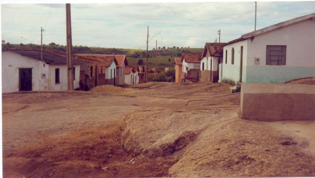
Foto 06 – Bairro Zarur, zona urbana. A urbanização sobre o granito em Nanuque é comum, até porque é inevitável fugir deles, pois estão expostos por toda a parte urbana do município-sede. Aqui uma rua sobre um único bloco de granito, mostrando que a população se adapta às formas do relevo onde habita. Os alicerces das casas são a própria rocha-mãe. O autor, 2000.
