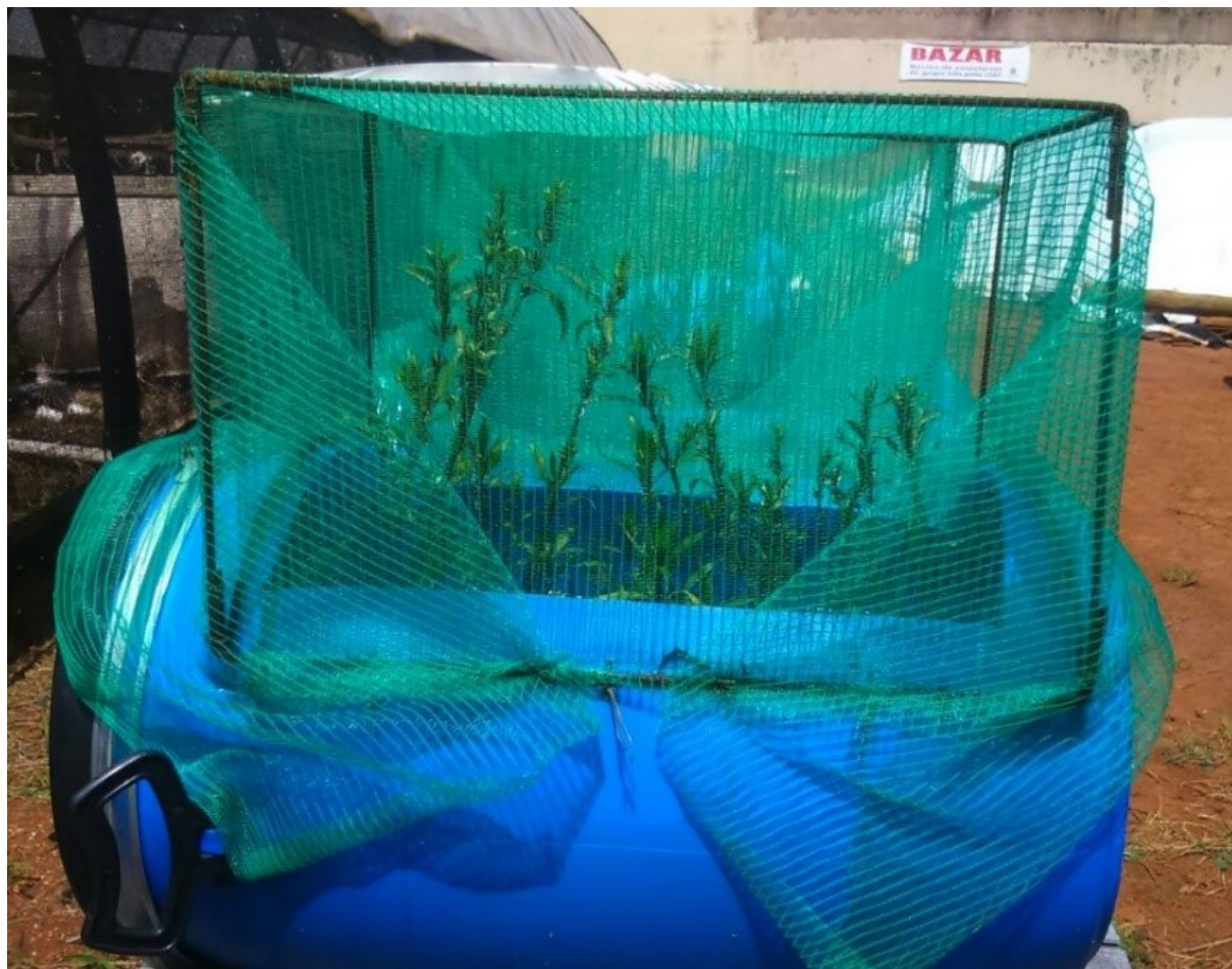
Figura 6 - Rede de proteção sobre o leito.
