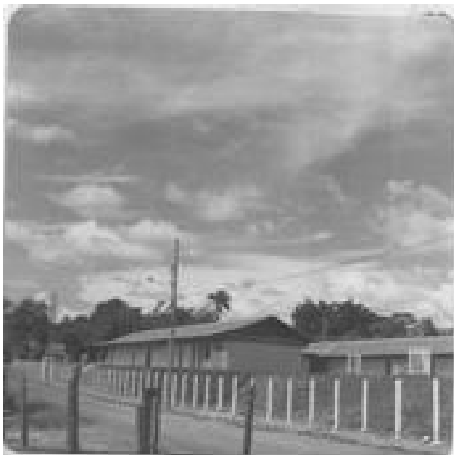
Figura 133 – Escola Estadual Robert Kennedy quando da finalização de sua construção na década de 1970.
