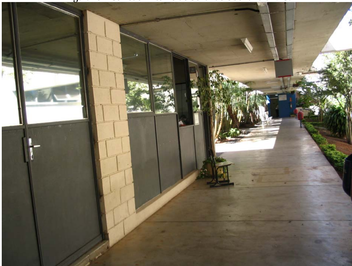
Figura 13 – Corredor interno do Senai de Uberlândia-MG.
