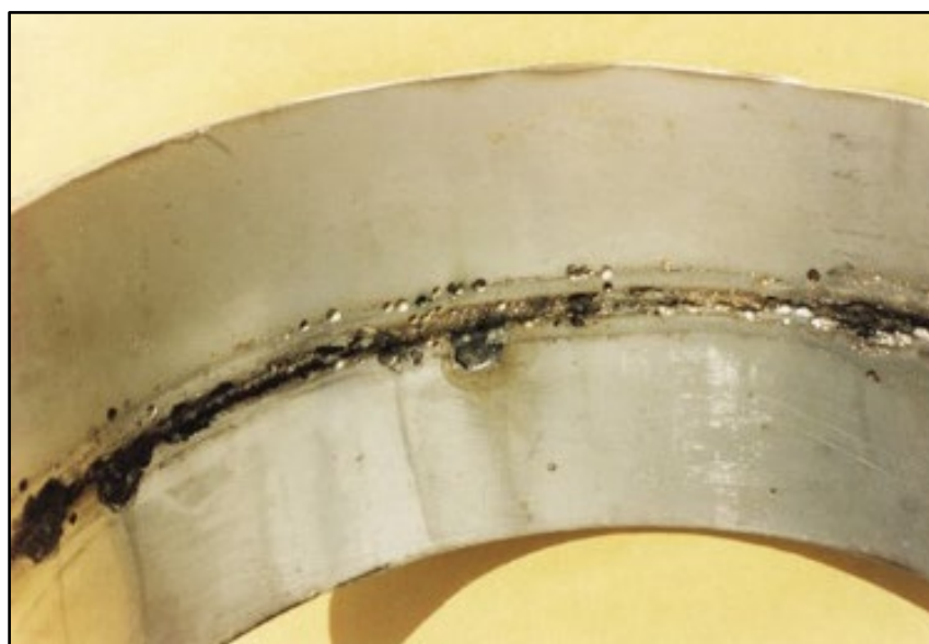
Figura 23- Corrosão PIT na ZAC (Gentil, 2003)
