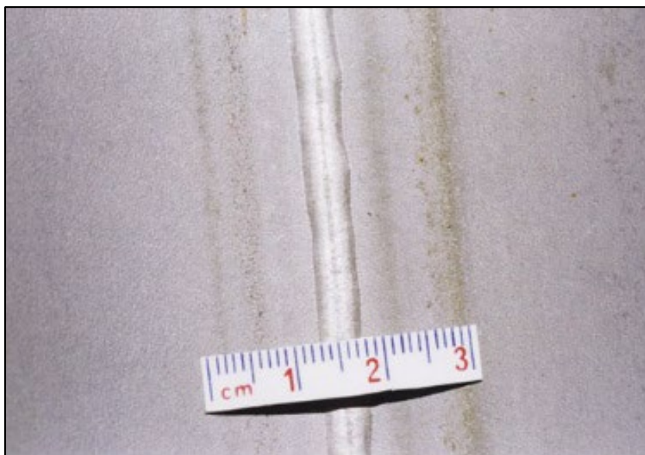
Figura 22 - Corrosão ZAC (Gentil, 2003)
