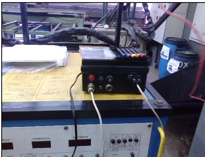
Figura 30 - Equipamento para captação de sinais de I e V
