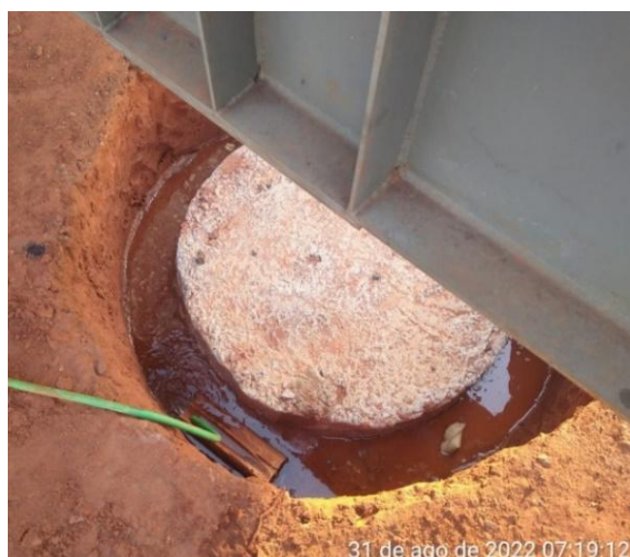
Figura 28 – Pré-inundação de solo para prova de carga em sapata isolada.
