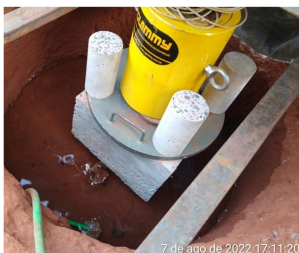
Figura 24 – Pré-inundação de solo para prova de carga em estaca isolada.
