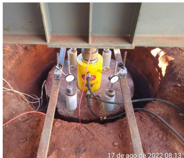
Figura 27 – Prova de carga em sapata estaqueada com solo em estado inundado.
