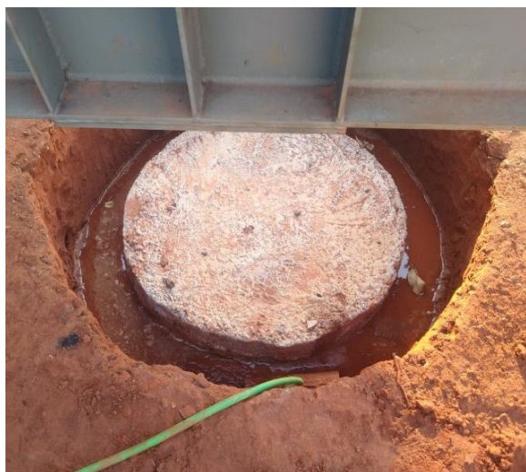
Figura 26 – Pré-inundação de solo para prova de carga em sapata estaqueada.
