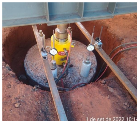
Figura 29 – Prova de carga em sapata isolada com solo em estado inundado.
