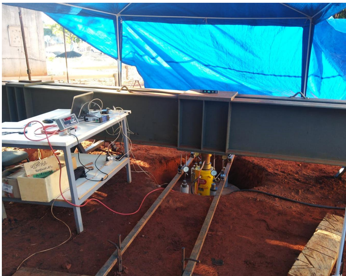
Figura 23 – Viga de reação e equipamentos posicionados para a prova de carga da sapata estaqueada.
