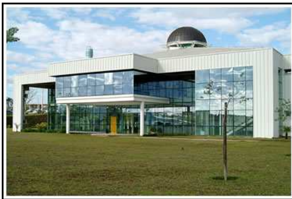
Figura 2 – Fachada da Unialgar onde foi instalado o vidro autolimpante BIOCLEAN
