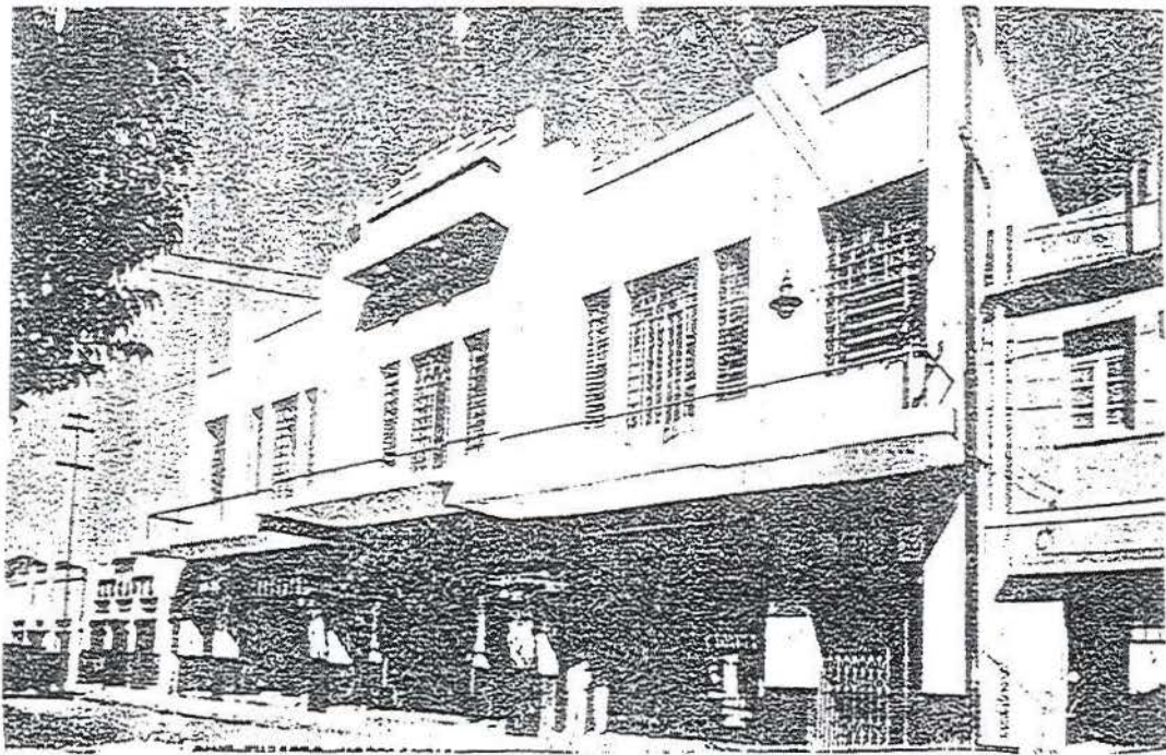
Fachada do Cine Teatro Uberlândia
