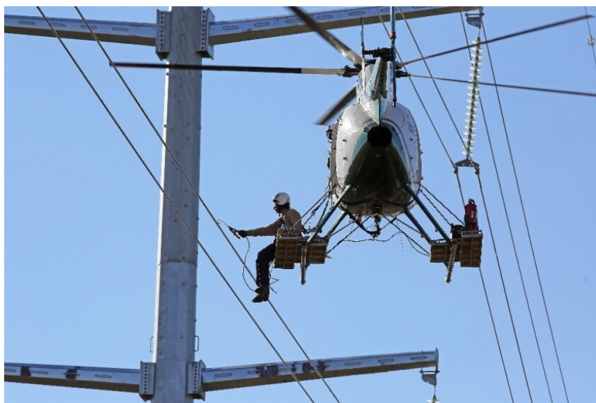
Figura 4 - Manutenção de cabos com auxílio de helicóptero.
