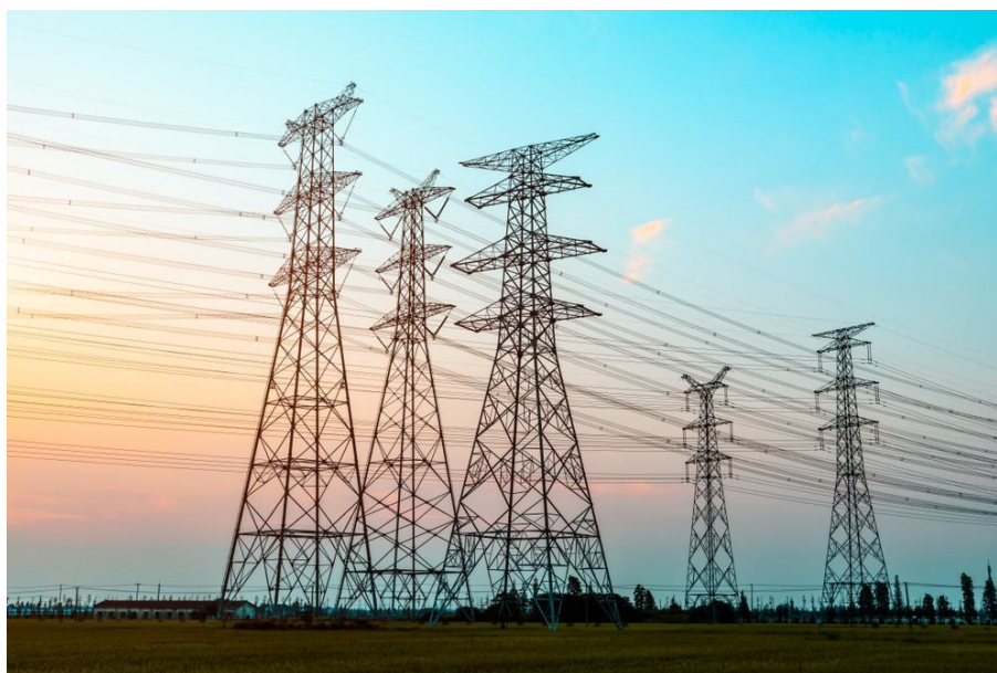
Figura 1 - Torres de transmissão de alta tensão.
