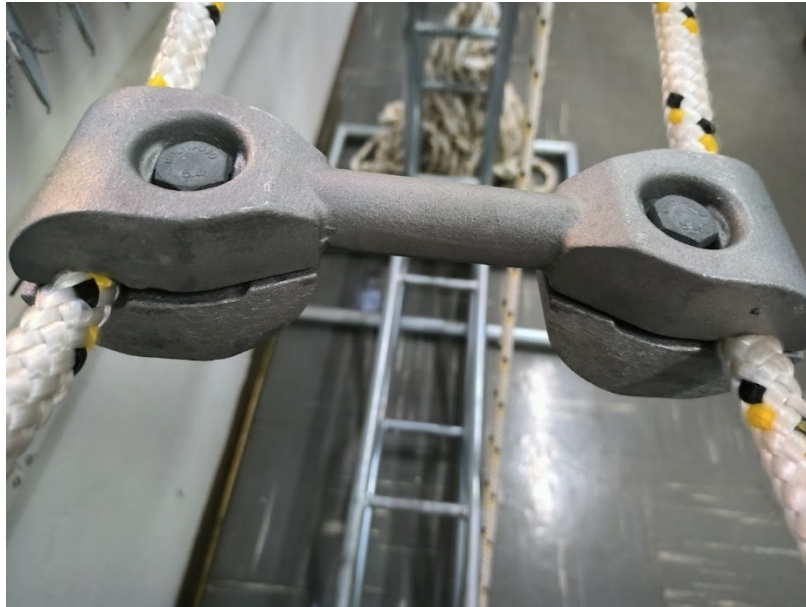
Figura 32 - Espaçador instalado nos cabos de teste.
