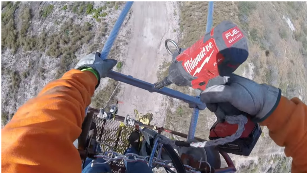
Figura 3 - Substituição manual de um espaçador de dois cabos através de um carrinho ( Buggy ).
