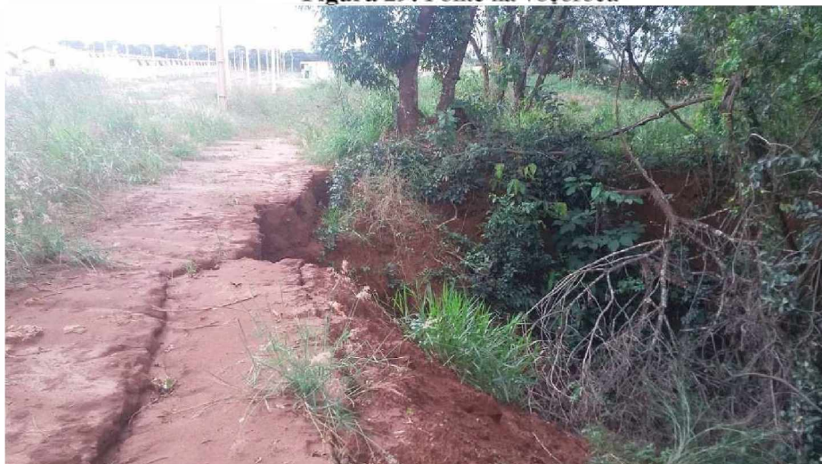
Figura 29: Ponte na voçoroca
