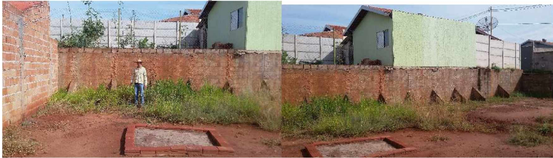
Figura 17: Muros de Arrimo
