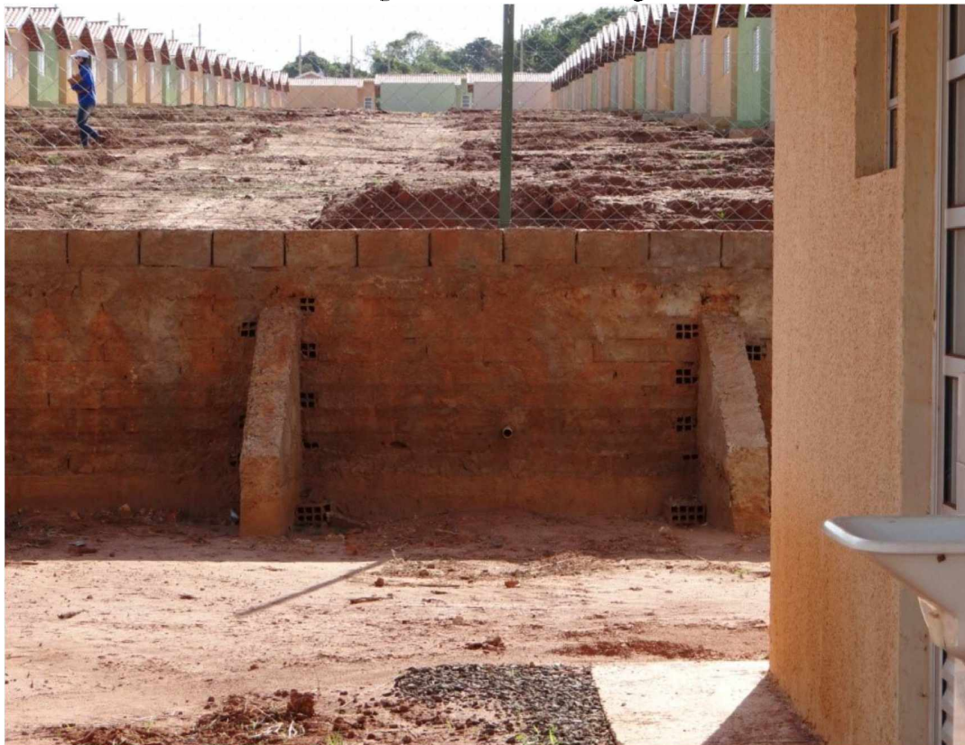
Figura 31: Cano de drenagem
