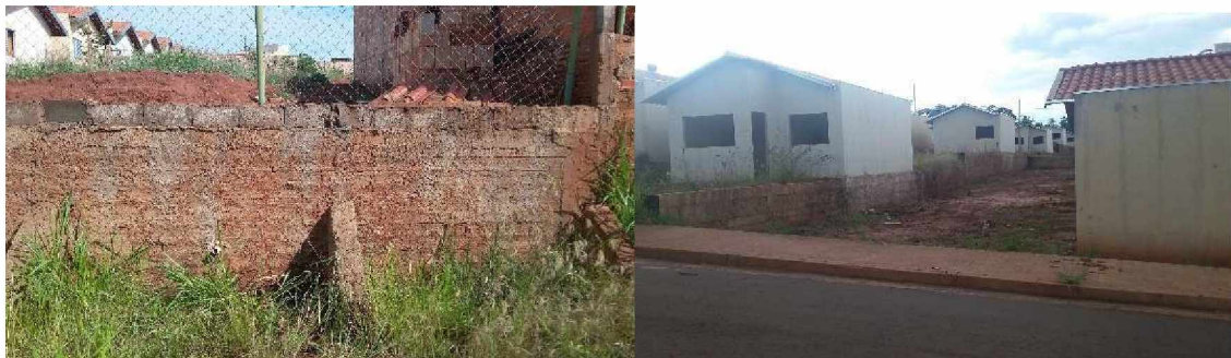
Figura 18: Muros de Arrimo 2
