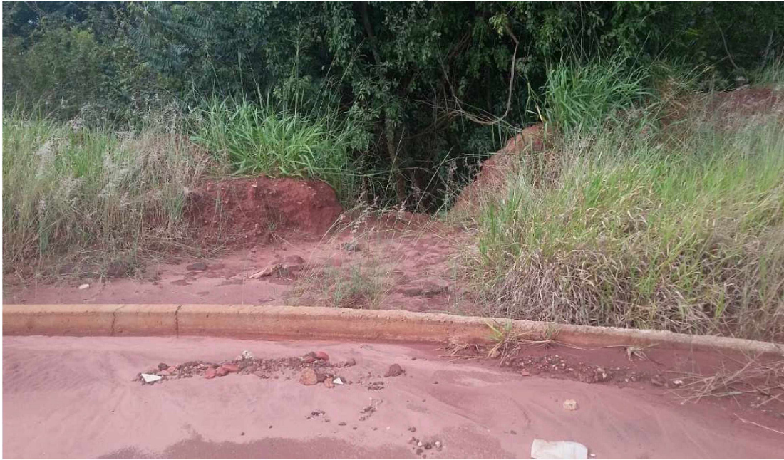
Figura 25: Transporte de solo
