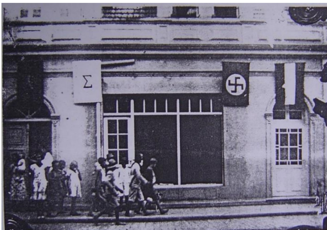
FIGURA 14- Sedes da Ação Integralista e do Partido Nazista dividindo o mesmo prédio em Rio do Sul (SC) na década de 1930
