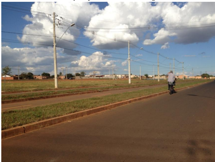
Foto 6: Uberlândia: ciclovia recentemente inaugurada às margens da R. Zulma Costa Vidala, em bom estado de conservação, porém ciclista trafegando ao lado da ciclovia
