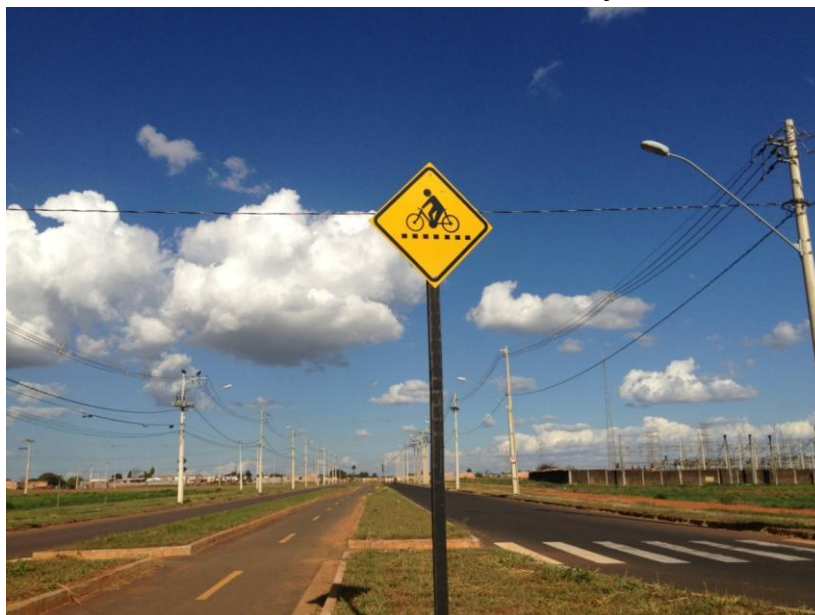
Foto 5: Uberlândia: ciclovia em bom estado de conservação R. Zulma Costa Vidala
