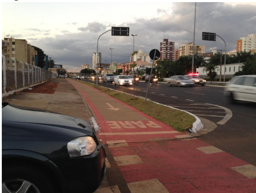
Foto 7: Uberlândia: ciclovia recentemente inaugurada, às margens da Avenida Rondon Pacheco, em bom estado de conservação
