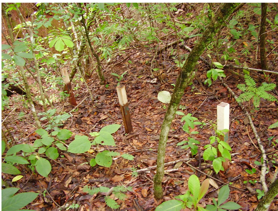
Figura 17: Seção 5 – Estação Experimental Boa Vista – Esta seção se mostra estabilizada devido à vegetação existente no local, barrando a velocidade da água e auxiliando na infiltração da mesma. Autor: VIEIRA,W.C. – jan/2005
