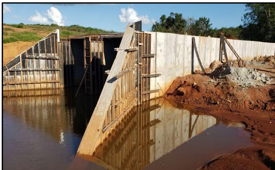
Foto 19 - Obra de canalização de leito de curso d'água para passagem do Arco Viário em Catalão (GO), realizada em Março de 2020, com secção do curso e supressão de Mata Galeria
