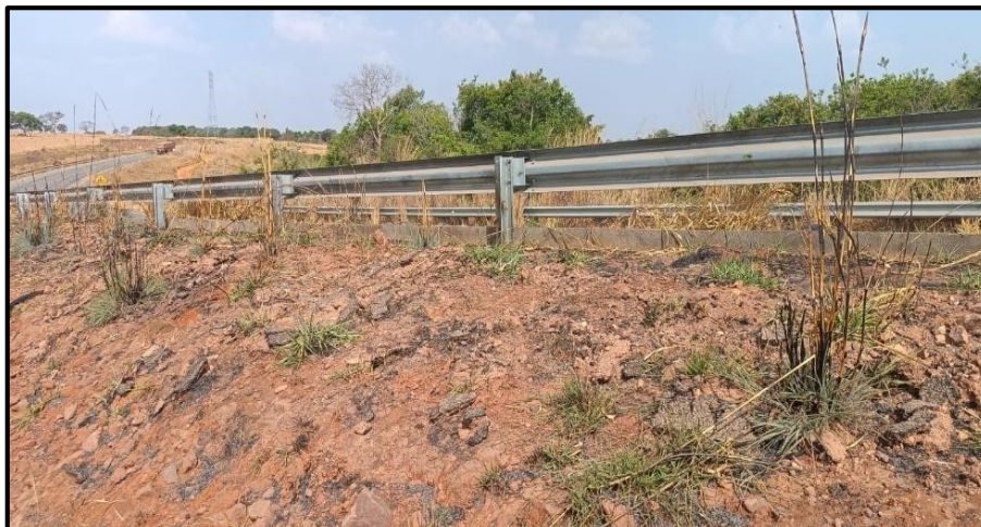
Foto 20 - Obra de construção do Anel Viário de Catalão com colocação de defensas metálicas, dificultando a transposição por animais, Junho de 2023
