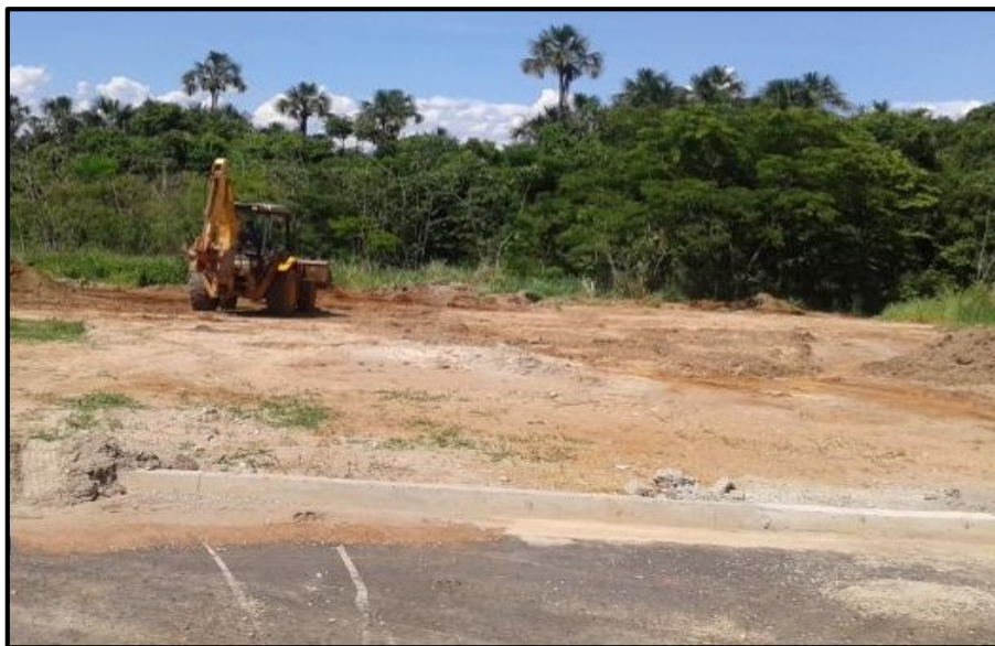
Foto 15 - Retirada da cobertura vegetal próximo APP de Nascente recuperada em 2008, área urbana de Catalão (GO), Loteamento Morada do Sol
