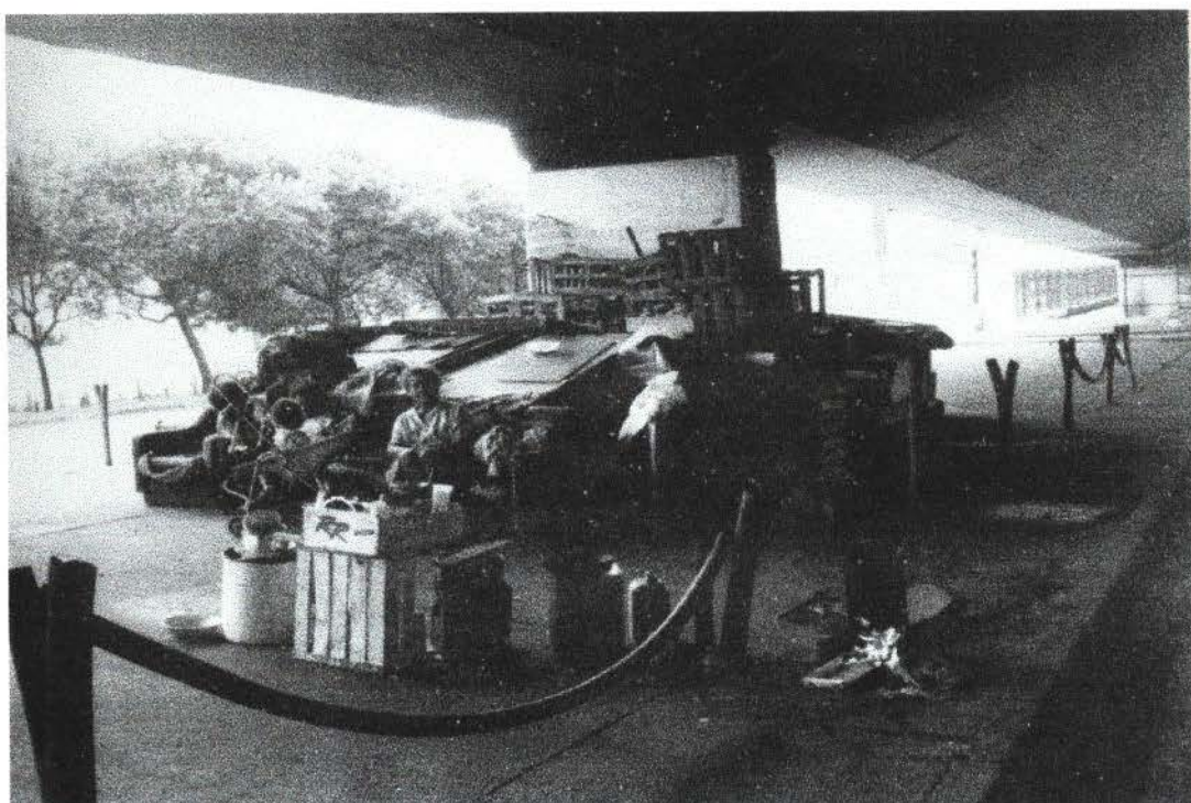
Habilitação de uma família. O teto é o viaduto. Fato: Gerson Zanini.
