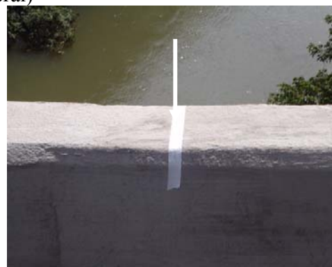
Figura 3.31: Detalhe da divisão da seção transversal do rio Uberabinha, através de marcações na ponte
